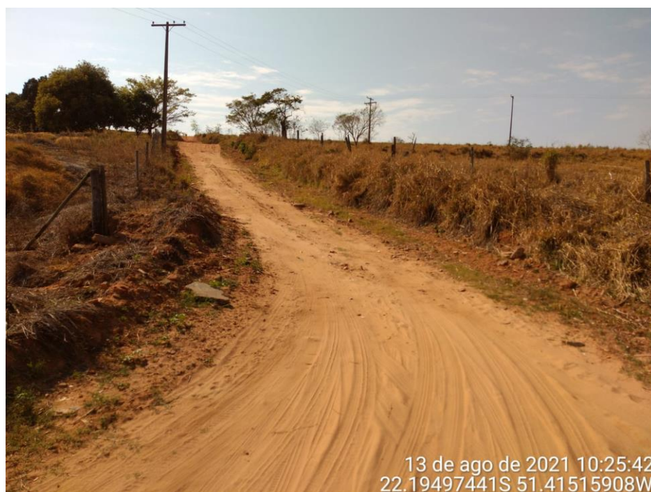
Imagem 4. Derivação da Estrada do Bom Pastor encaixada, com presença de barrancos laterais e acúmulo de areia nas baixadas.
