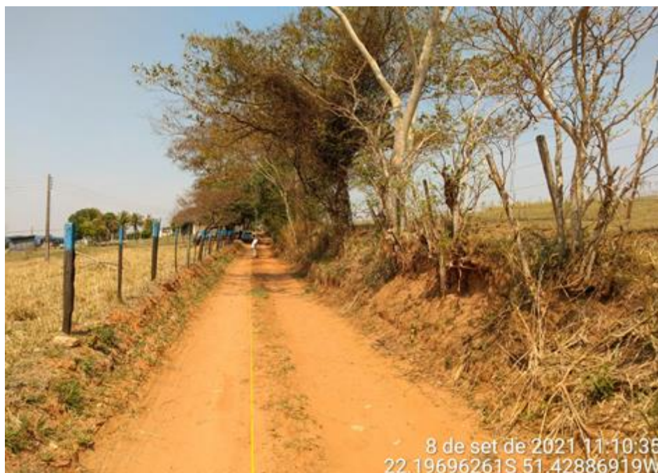
Imagem 7. Estrada do Condomínio Santa Fé, com leito encaixado, presença de barrancos laterais e árvores adjacentes ao traçado.
