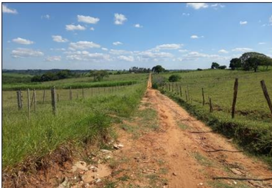
Imagem 1. Derivação da Estrada do Banco da Terra com leito encaixado, apresentando barrancos laterais e processo erosivo acelerado.
