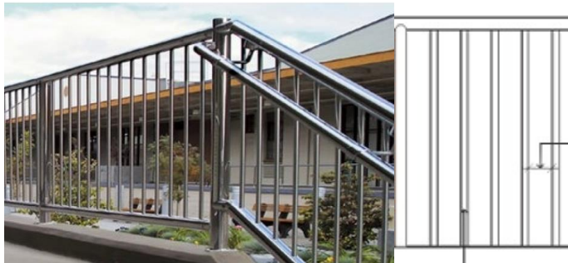
Guarda corpo associado ao corrimão.
