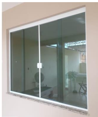
Janela de correr, em vidro temperado.
