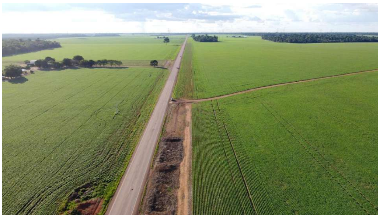
Foto 37 e 38– Vista aérea da rodovia MT-140.
