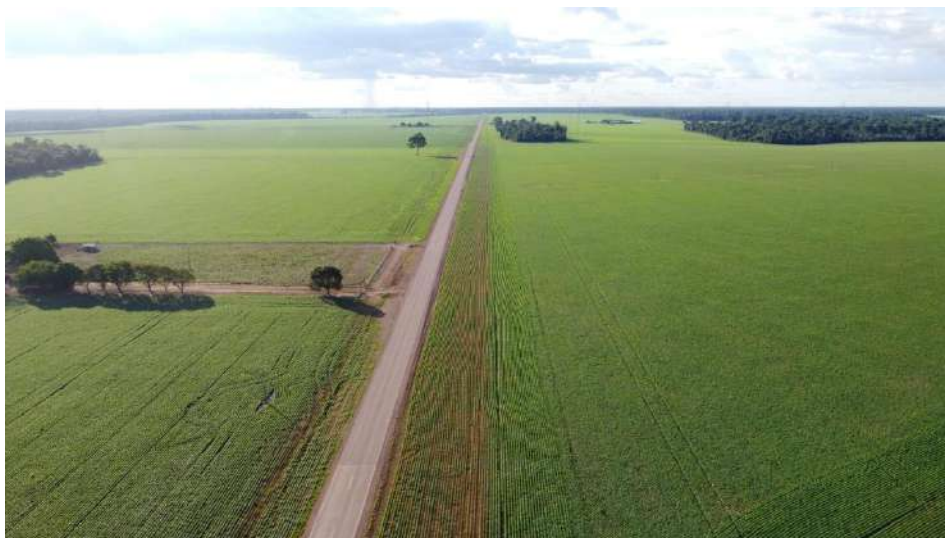
Foto 01, 02 e 03 – Imagem do trecho da MT-140
