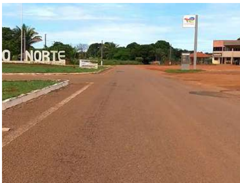
Figura 5-24 - Trecho da MT-412 objeto do Projeto de Restauração
