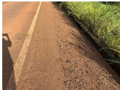
Figura 5-15 - Trecho da MT-412 objeto do Projeto de Restauração
