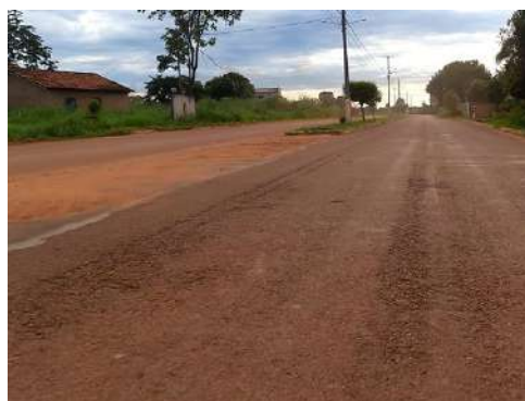
Figura 5-23 - Trecho da MT-412 objeto do Projeto de Restauração
