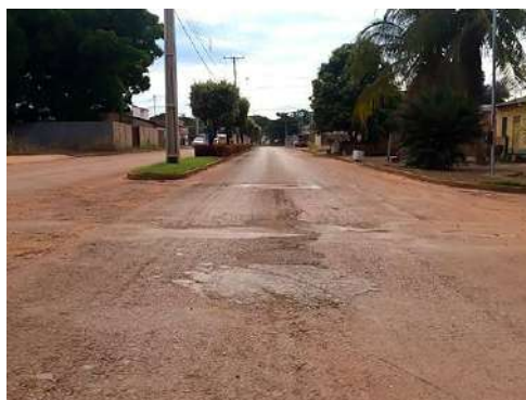
Figura 5-20 - Trecho da MT-412 objeto do Projeto de Restauração
