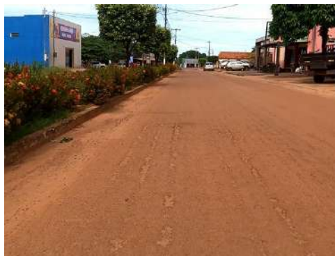
Figura 5-25 - Trecho da MT-412 objeto do Projeto de Restauração
