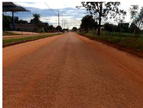
Figura 5-19 - Trecho da MT-412 objeto do Projeto de Restauração
