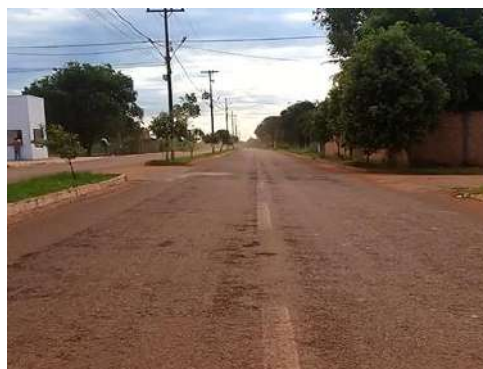
Figura 5-21 - Trecho da MT-412 objeto do Projeto de Restauração
