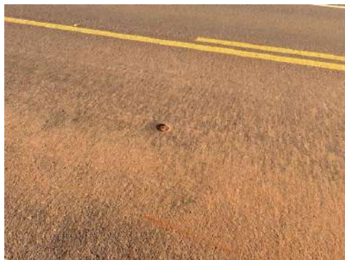
Figura 5-18 - Trecho da MT-412 objeto do Projeto de Restauração
