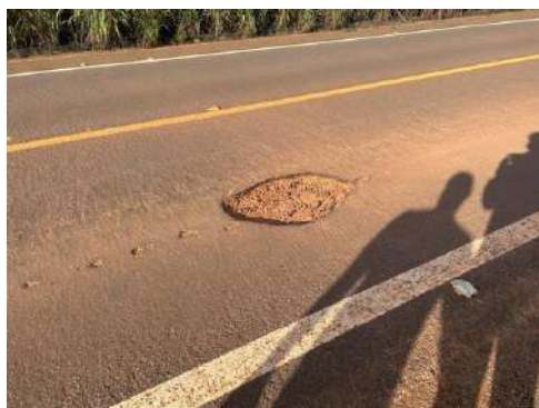
Figura 5-16 - Trecho da MT-412 objeto do Projeto de Restauração
