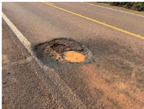
Figura 5-14 – Trecho da MT-412 objeto do Projeto de Restauração
