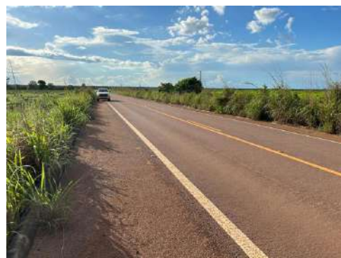
Figura 5-17 - Trecho da MT-412 objeto do Projeto de Restauração
