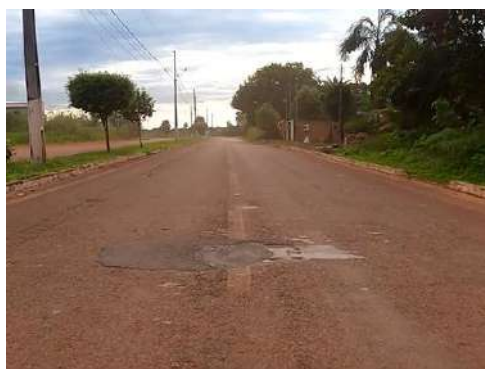
Figura 5-22 - Trecho da MT-412 objeto do Projeto de Restauração
