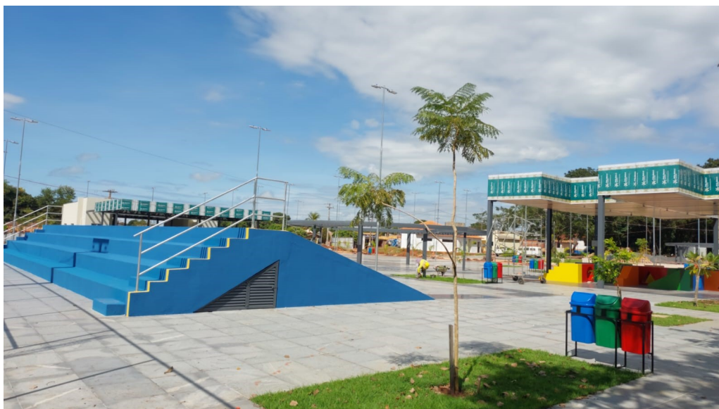
Figura 6. Execução da obra da Praça Central no Distrito de Bom Jardim, Nobres-MT.
