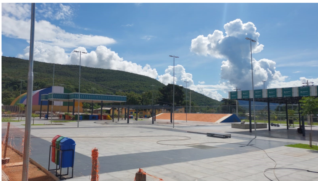
Figura 5. Execução da obra da Praça Central no Distrito de Bom Jardim, Nobres-MT.
