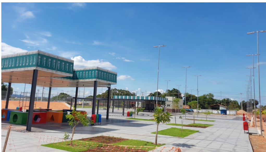
Figura 7 Execução da obra da Praça Central no Distrito de Bom Jardim, Nobres-MT.
