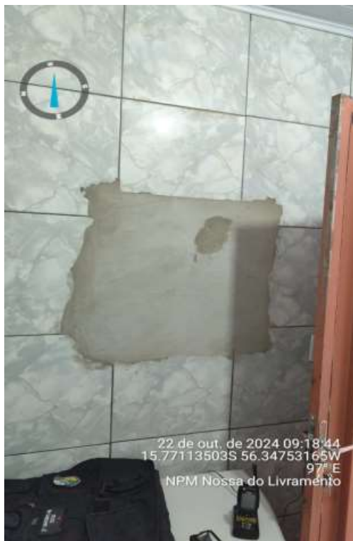
Figura 18: Pare interna do almoxarifado com intervenções.
