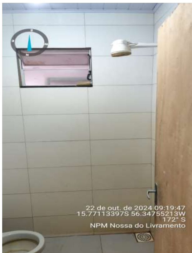
Figura 15: Banheiro da sala do comandante.
