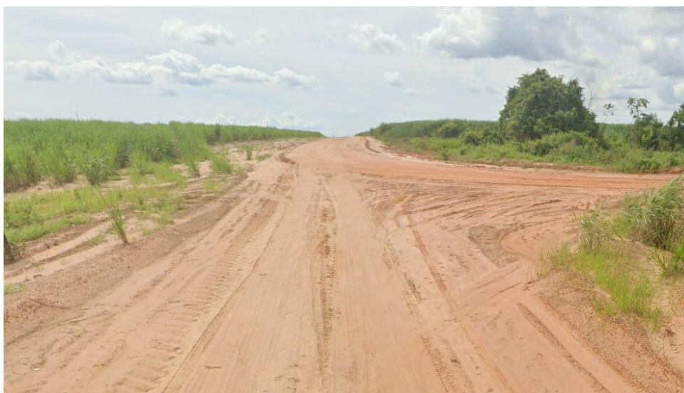
Figura 5 - Estaca 1200 – Entroncamento com a MT-408
