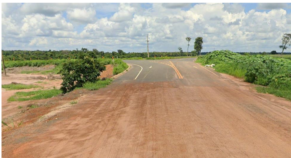
Figura 7 - Estaca 2194+19,75 – Entroncamento com a MT-339
