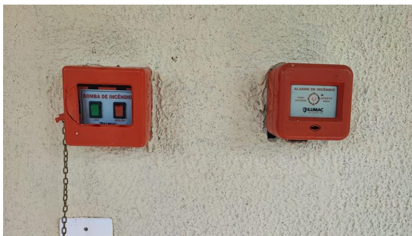
Figura 15 – Acionador de Bomba e Alarme (imagem própria)
