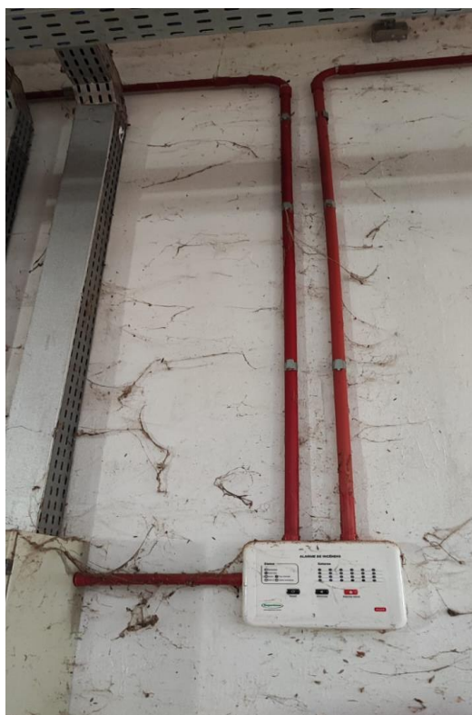
Figura 15 – Acionador de Bomba e Alarme (imagem própria)
