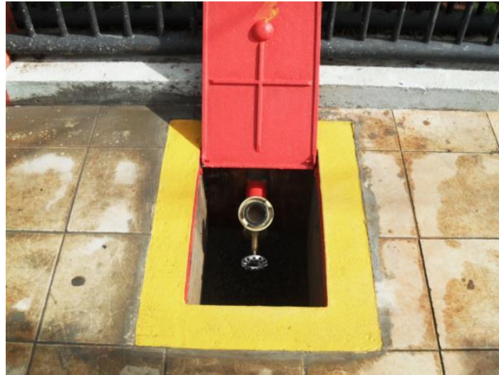
Figura 19.1 - Hidrante – Recalque
