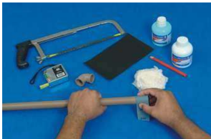
Figura 36. Execução da tubulação soldável - 1º passo.
