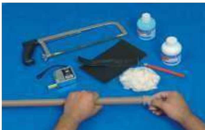
Figura 39. Execução da tubulação soldável - 4º passo.
