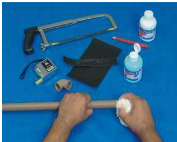
Figura 37. Execução da tubulação soldável - 2º passo.
