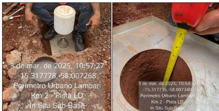
Figura 18 - Ensaio de Densidade In-Situ
