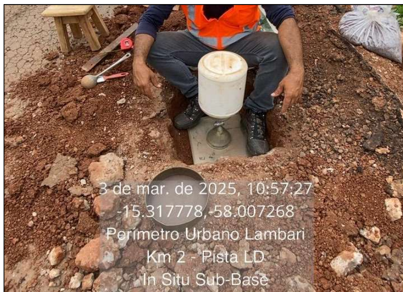
Figura 15 - Execução do ensaio de umidade e densidade in situ.
