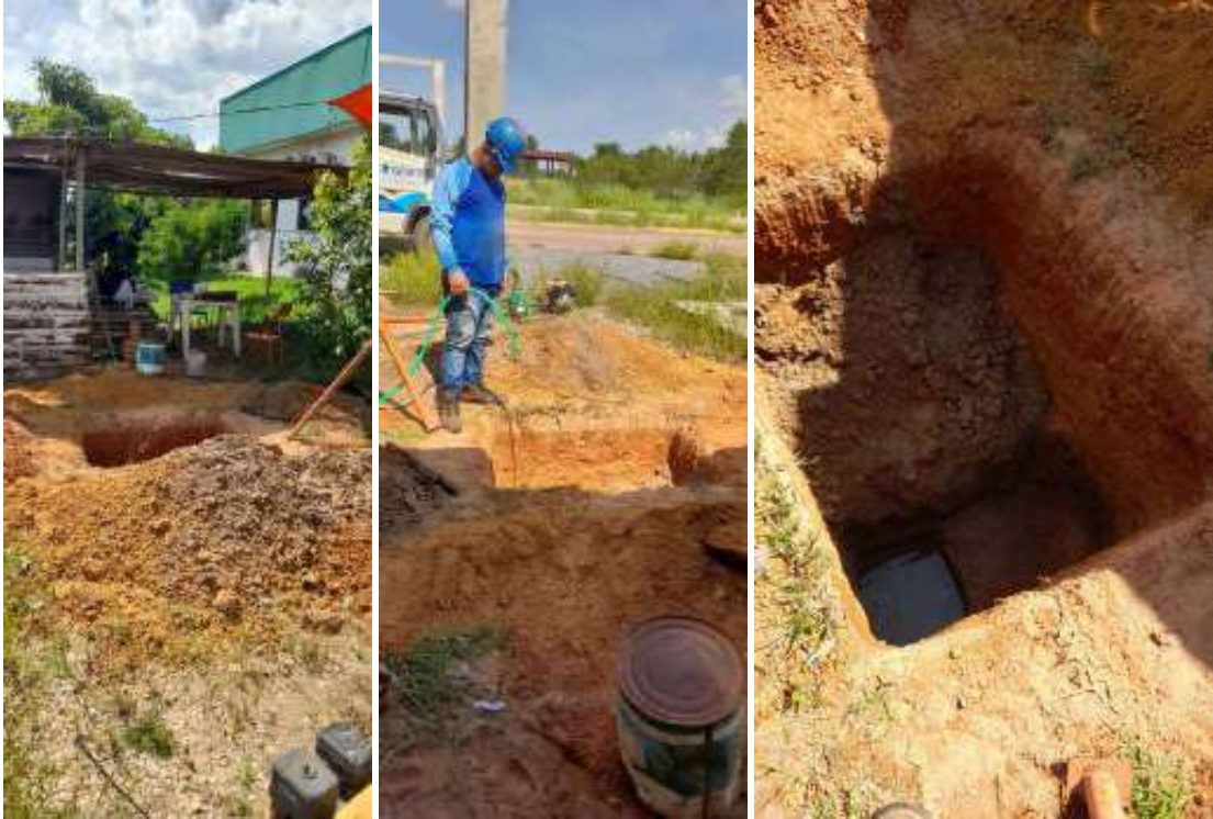
Quadro 2- Execução do ensaio de cova cúbica na base do Gefron no “trevo do limão”.
