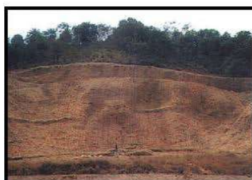
Foto 2 - Biomanta Antierosiva aplicada após outras intervenções de Bioengenharia, mudando imediatamente o aspecto visual do local, proporcionando rápida instalação da vegetação
