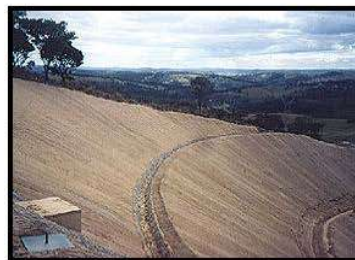
Foto 11 - A proteção dos taludes foi feita com biomanta antierosiva de fibra de coco bidimensional (Tela Fibrax® 400BF), protegendo imediatamente a área até o estabelecimento total da vegetação
