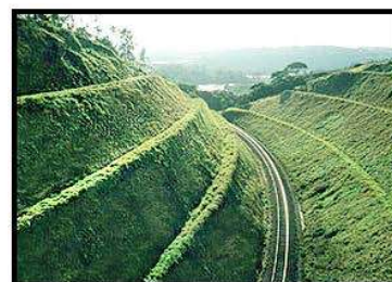
Foto 6 - Mesmo local imediatamente após a execução dos serviços, mostrando o aspecto visual, a proteção total dos taludes cuja superfície será coberta pela vegetação posteriormente
