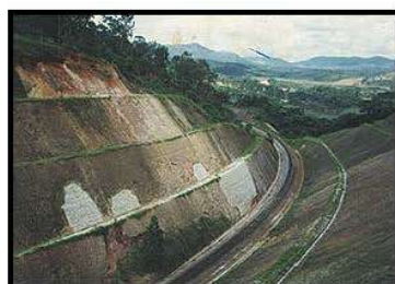
Foto 4 - Vista geral das erosões, as quais serão recuperadas com uso das Técnicas de Bioengenharia e produtos biodegradáveis.
