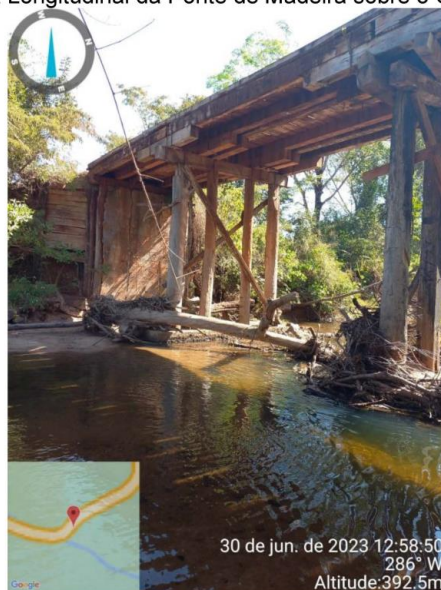
Figura 10 – Vista Longitudinal da Ponte de Madeira sobre o Córrego Avoadeira
