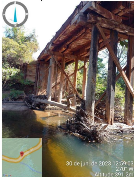
Figura 7 – Vista inferior da ponte de madeira sobre o Córrego Avoadeira
