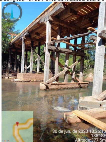
Figura 7 – Vista Longitudinal da Ponte de Madeira sobre o Ribeirão Estrela
