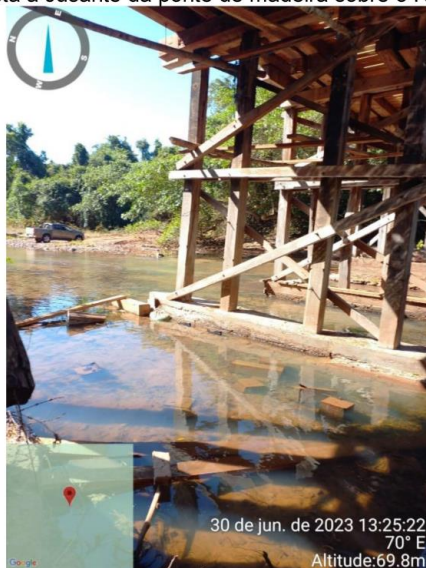
Figura 8 – Vista a Jusante da ponte de madeira sobre o Ribeirão Estrela
