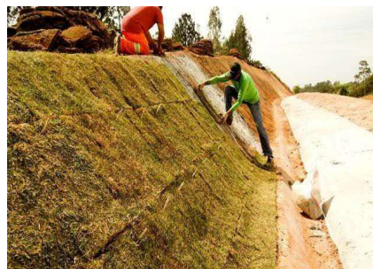
Figura 99 - Implantação da grama esmeraldas (Zoysia Japonica) em talude.
