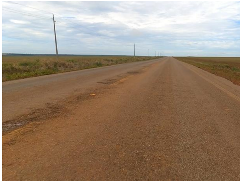
Figura 5-13 – Trecho da MT-249 objeto do Projeto de Restauração – início da formação de bacias na pista
