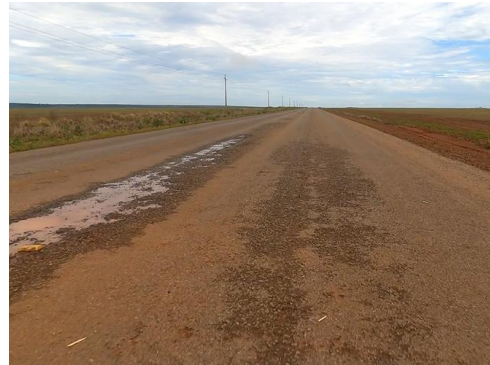
Figura 5-14 – Trecho da MT-249 objeto do Projeto de Restauração – acúmulo de água de chuva nas irregularidades da pista
