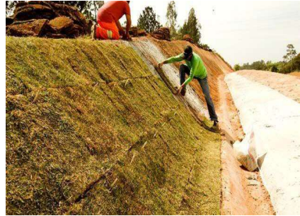
Figura 92 - Implantação da grama esmeraldas (Zoysia Japonica) em talude.
