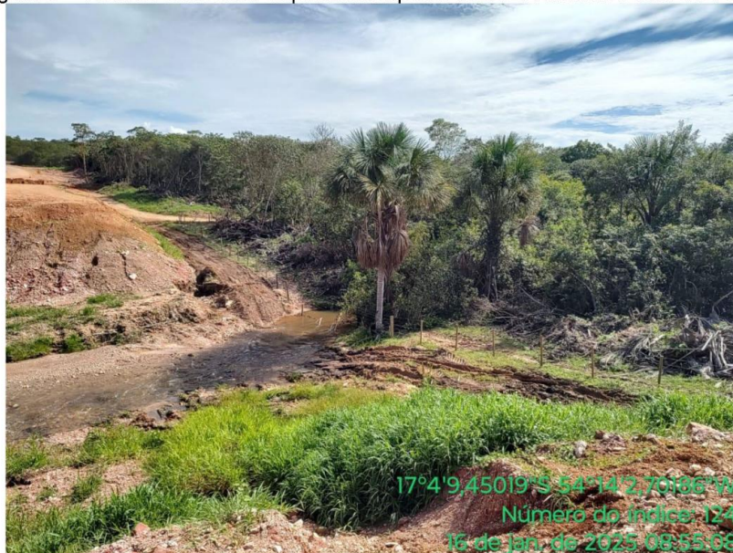
Figura 9 – Vista do local a ser implantada a ponte sobre o Ribeirão Ponte de Pedra
