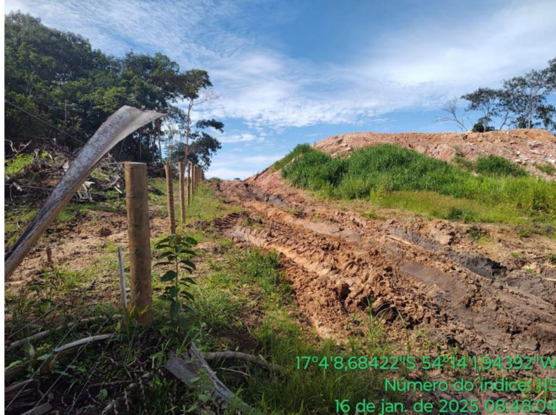
Figura 13 – Vista do local a ser implantada a ponte sobre o Ribeirão Ponte de Pedra
