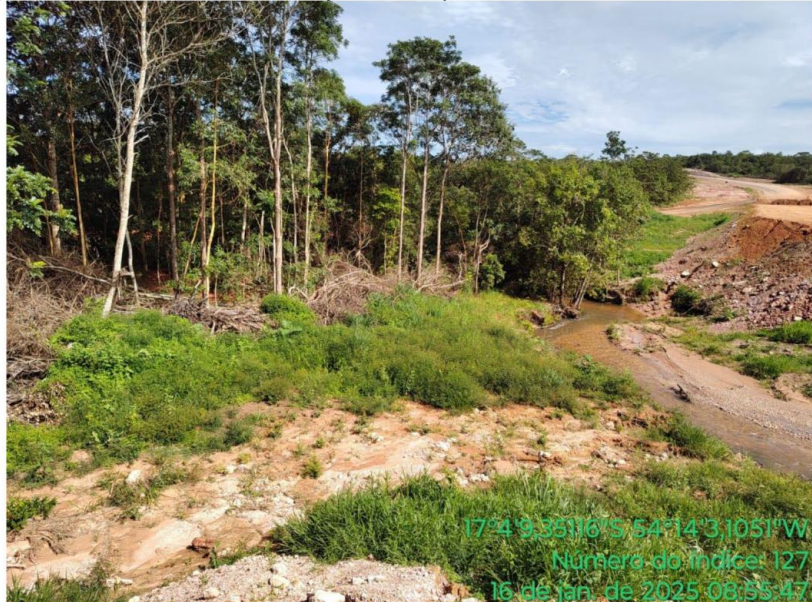
Figura 11 – Vista do local a ser implantada a ponte sobre o Ribeirão Ponte de Pedra
