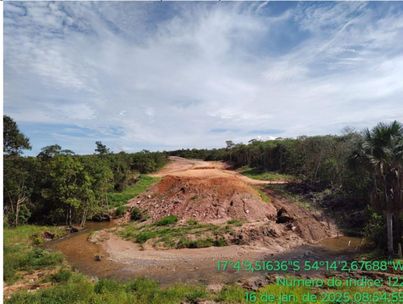
Figura 8 – Vista do local a ser implantada a ponte sobre o Ribeirão Ponte de Pedra
