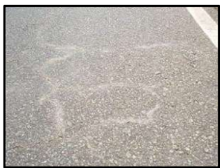
Trinca de severidade baixa. Trinca de severidade média. Trinca de severidade alta.
