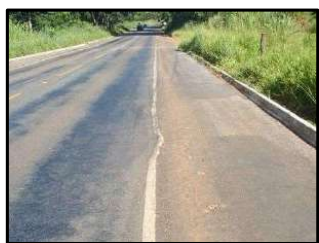
Escorregamento de Capa de severidade baixa
