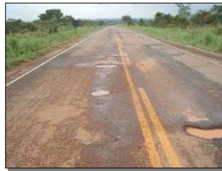
Painelas de intensidade baixa. Painelas de intensidade média. Painelas de intensidade alta.
