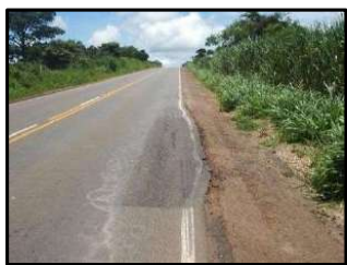
Escorregamento de Capa de severidade baixa
