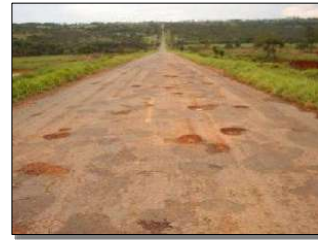
Painelas de intensidade baixa. Painelas de intensidade média. Painelas de intensidade alta.
