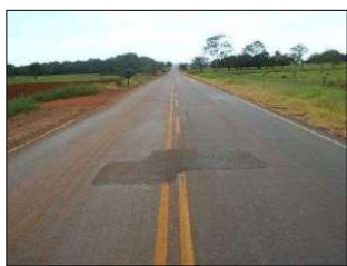
Remendos de intensidade baixa
