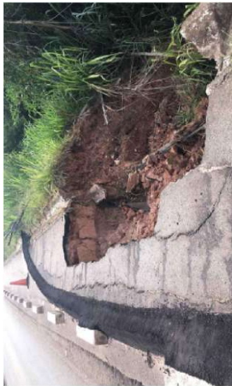
EROSÃO NO BORDO DA RODOVIA CAUSADO POR ROMPIMENTO DE SARRETA
