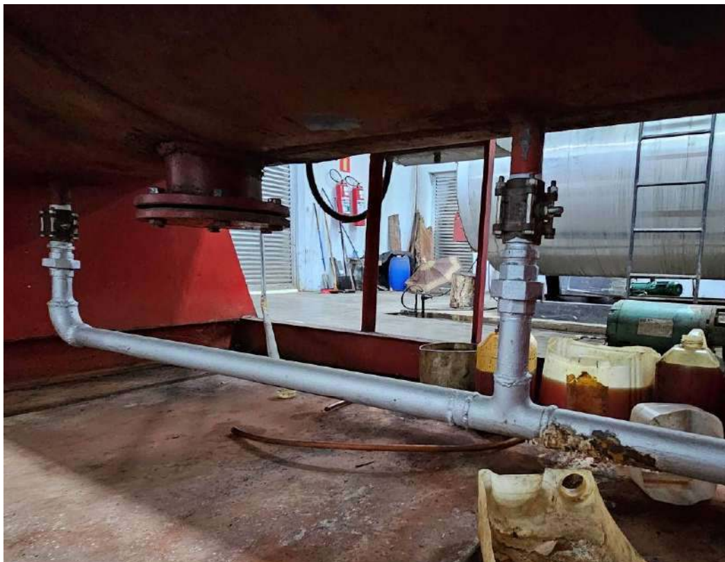
Fig. 11 Tubulação do Dreno.
