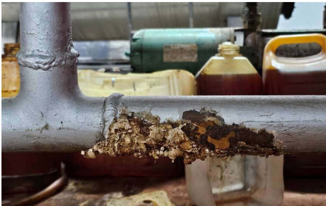
Fig. 14 Tubulação do Dreno.
