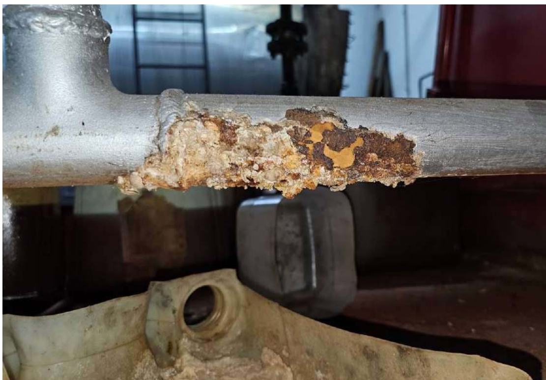
Fig. 15 Tubulação do Dreno.
