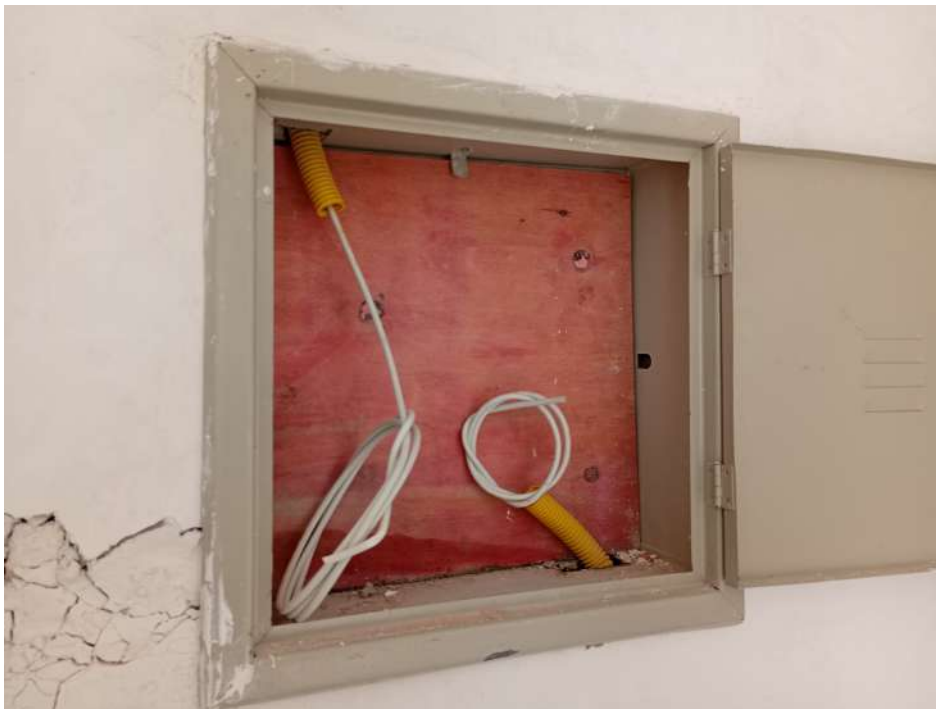
Foto 2 - Cabeamento de telefonia e internet
