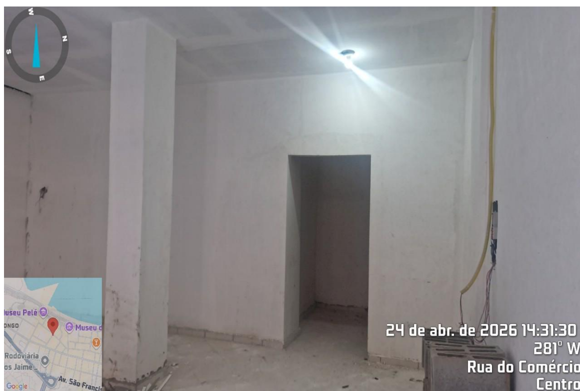
Figura 6 - Vista interna do Imóvel
