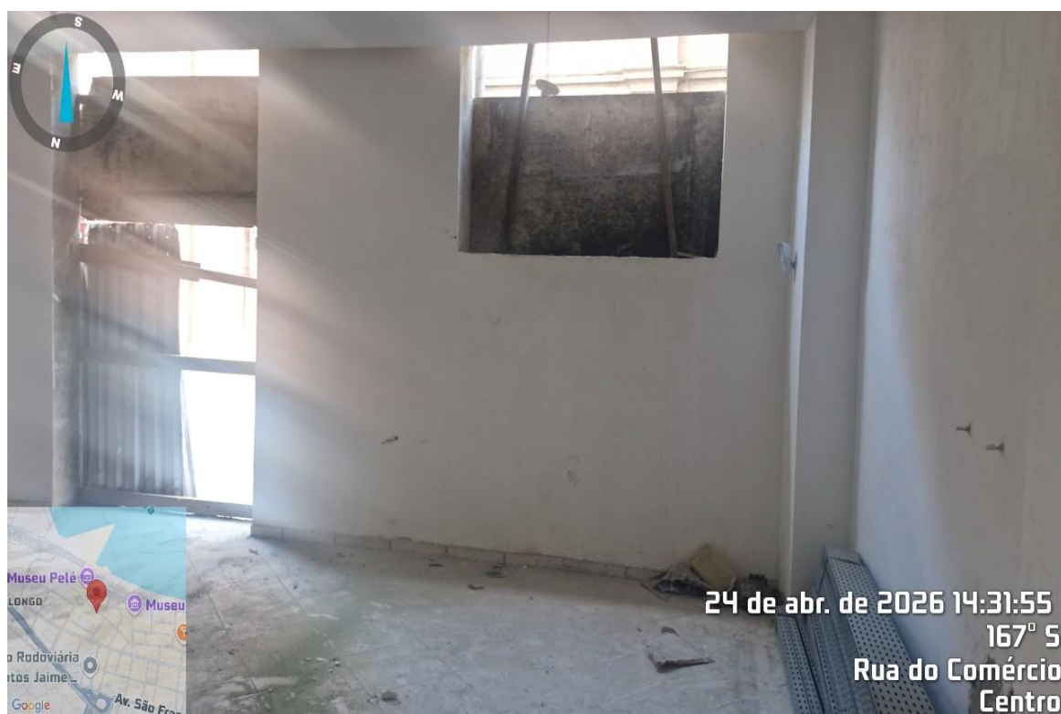
Figura 10 - Vista interna do Imóvel
