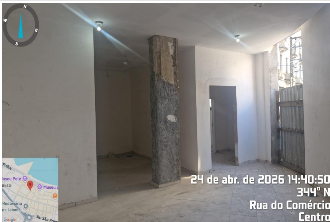
Figura 5 – Vista interna do Imóvel
