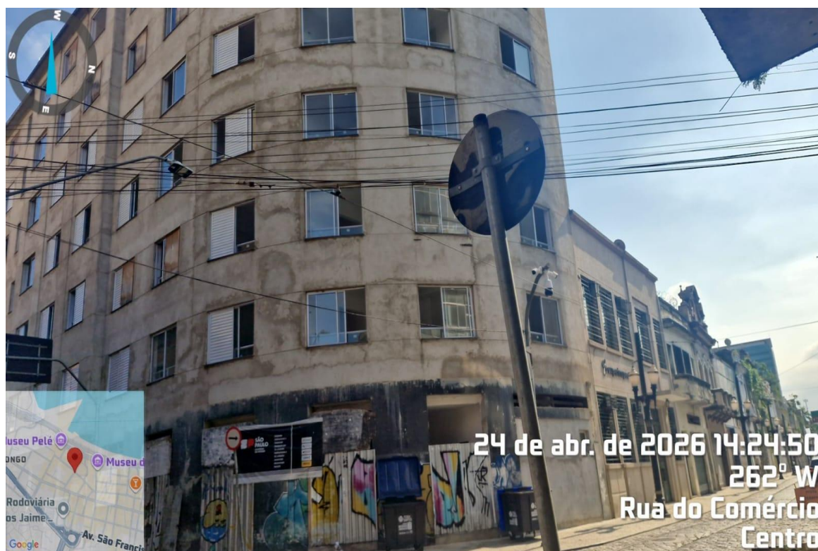
Figura 1- Vista de acesso ao imóvel avaliado
