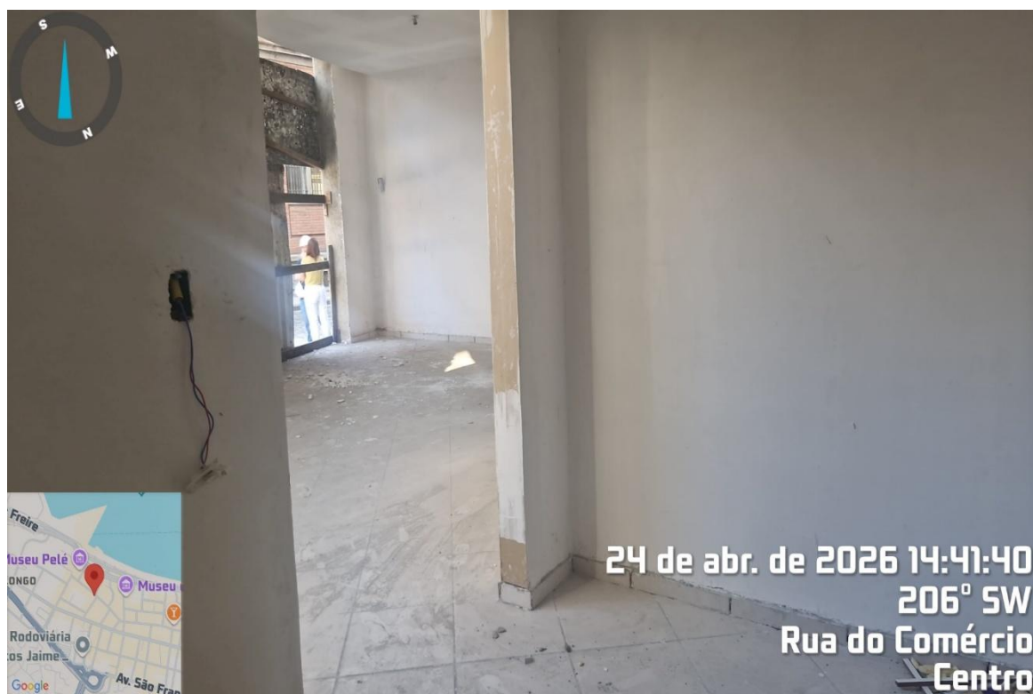
Figura 9 – Área de circulação do Imóvel
