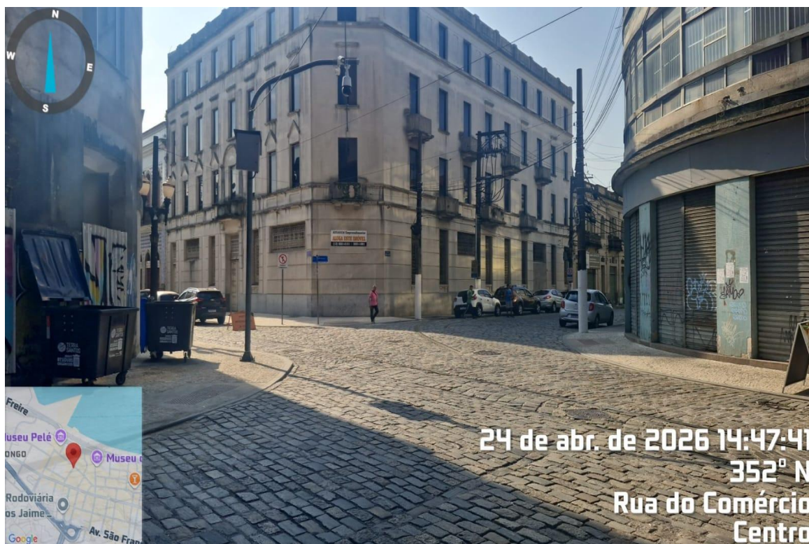
Figura 4 – Vista 2 do acesso lateral do Imóvel
