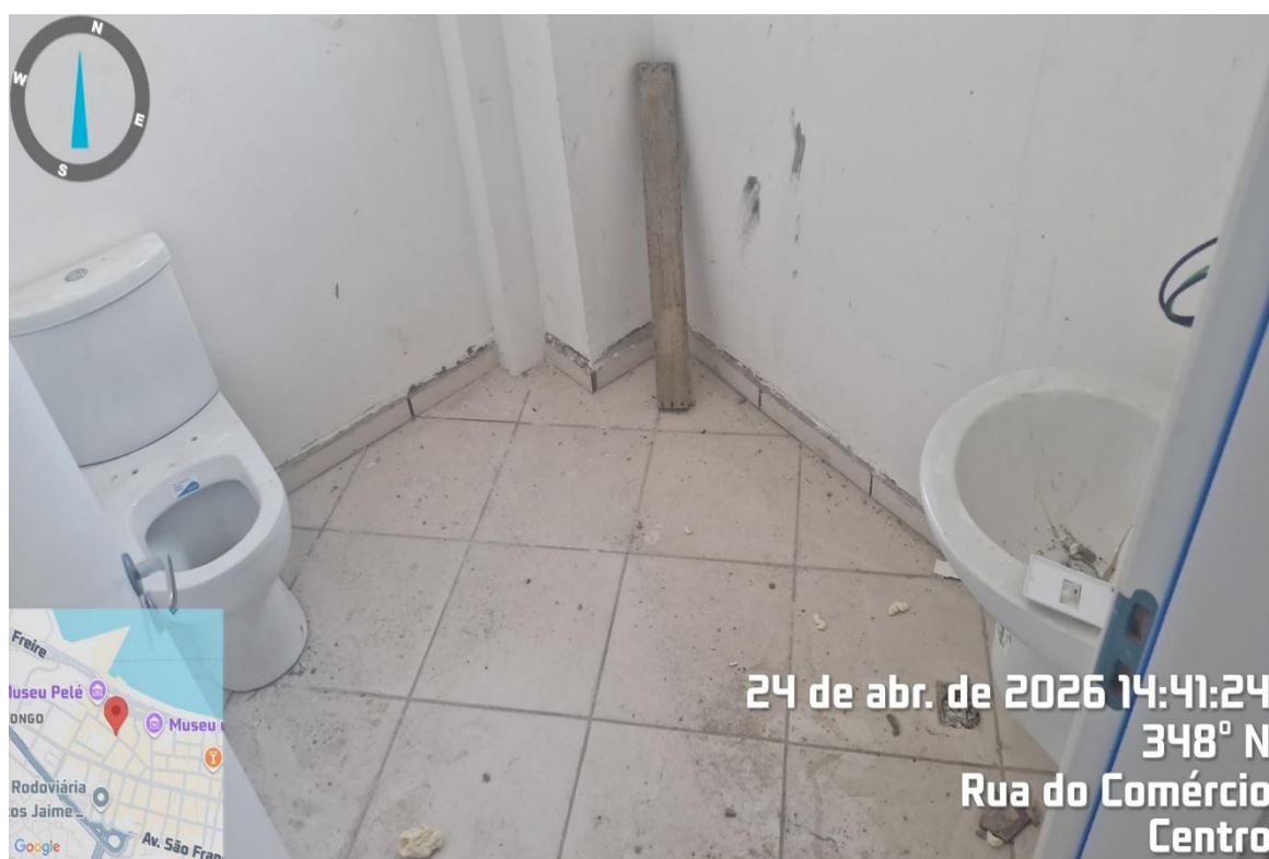
Figura 8 – Vista do banheiro do Imóvel
