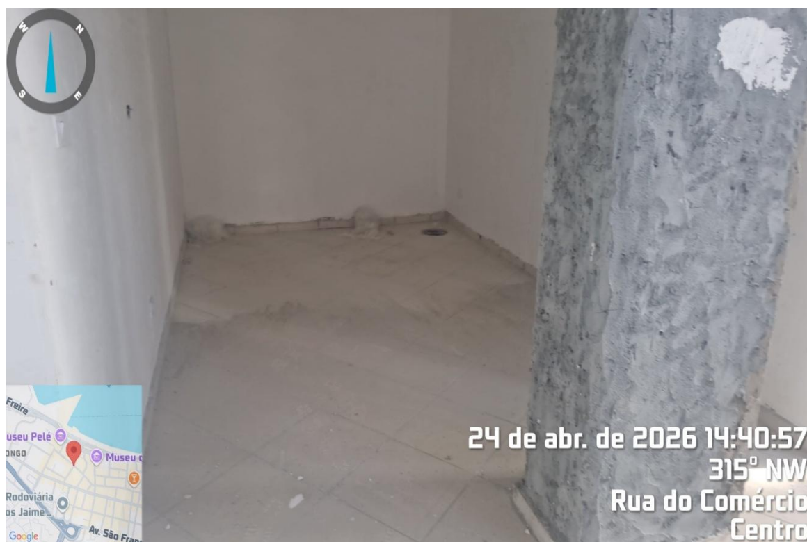
Figura 7 - Vista interna do Imóvel
