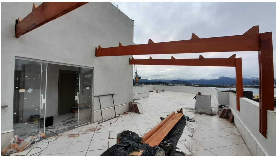
Foto 6 – Vista a esquerda da saída dos elevadores.
