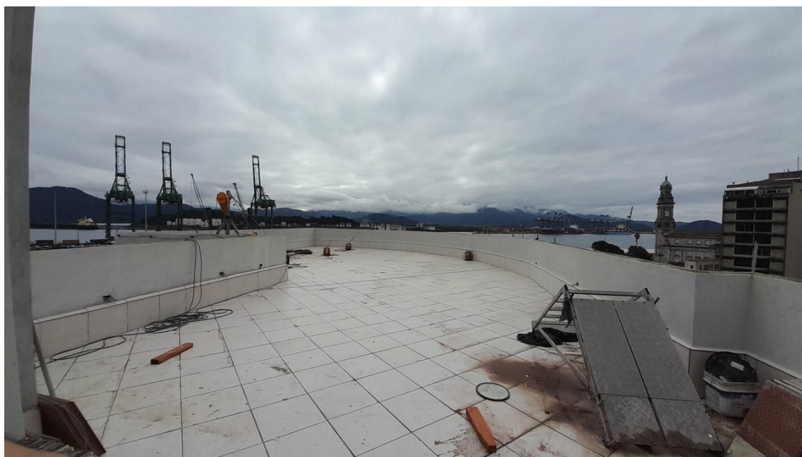
Foto 7 – Vista da parte comum do Rooftop.
