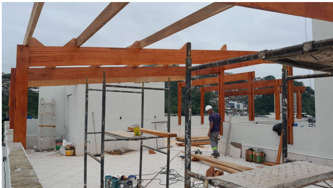
Foto 2 – Vista do Rooftop pela direita da saída dos elevadores.
