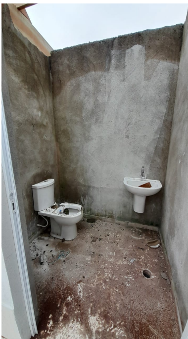
Foto 5 – Banheiro de frente a ponta direita da saída dos elevadores
