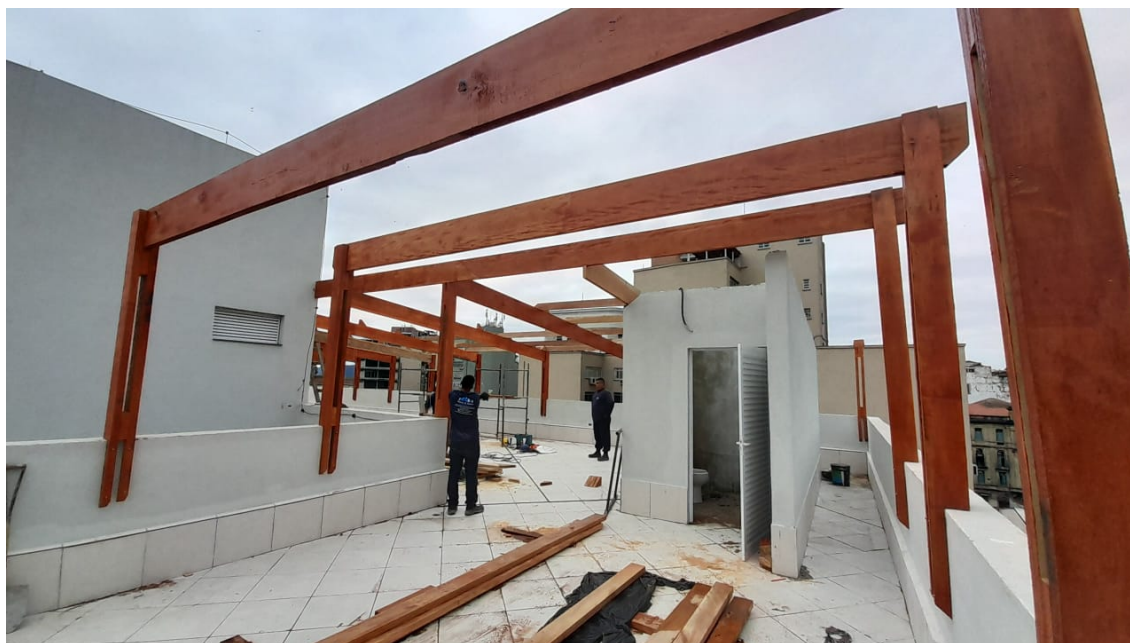
Foto 3 – Vista do Rooftop pela ponta direita da saída dos elevadores.
