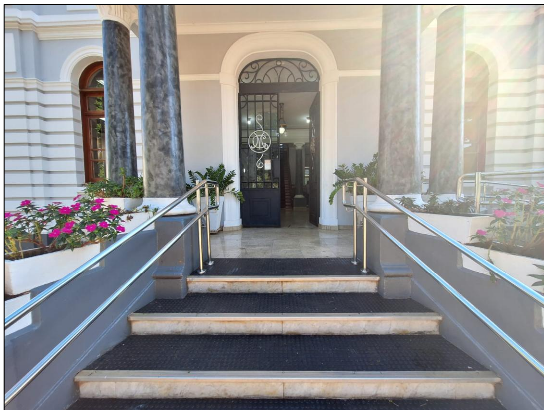
Figura 2. Saguão do Térreo (visão externa - fachada frontal do Prédio Histórico).
