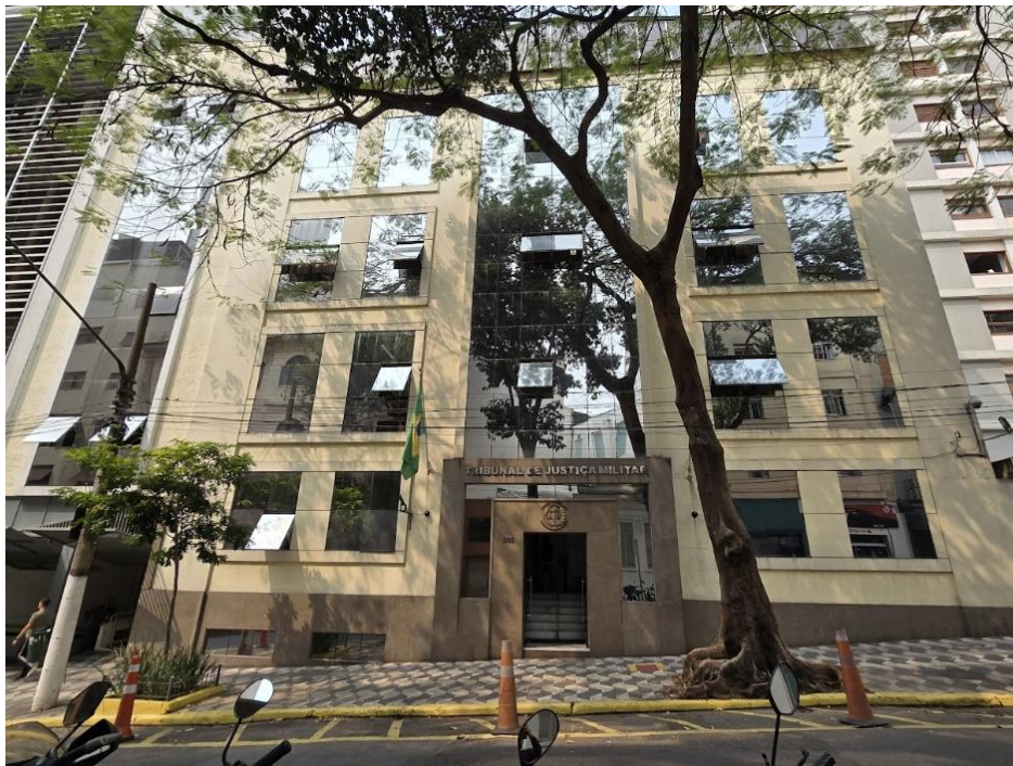
Figura 2 - Foto Fachada – Edifício Sede – TJMSP
