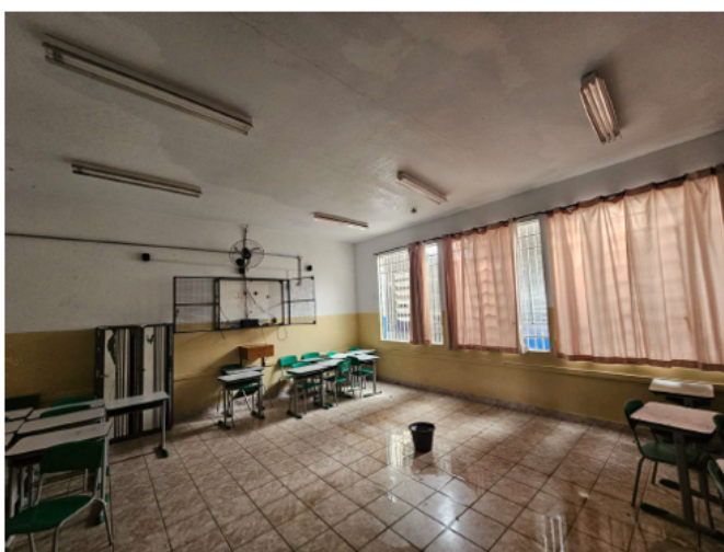
Figura 5: Laje úmida com goteiras.
