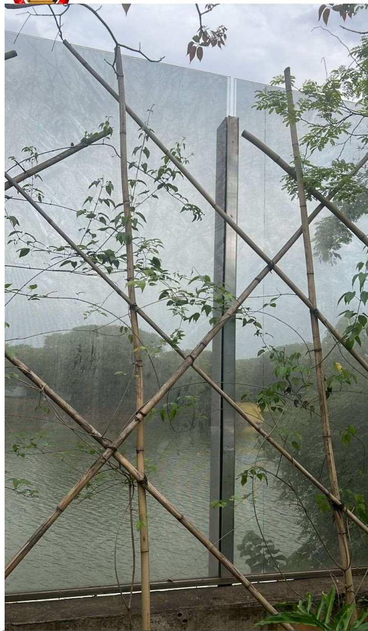
1A – Estrutura atual de tramas que deverá ser continuada
