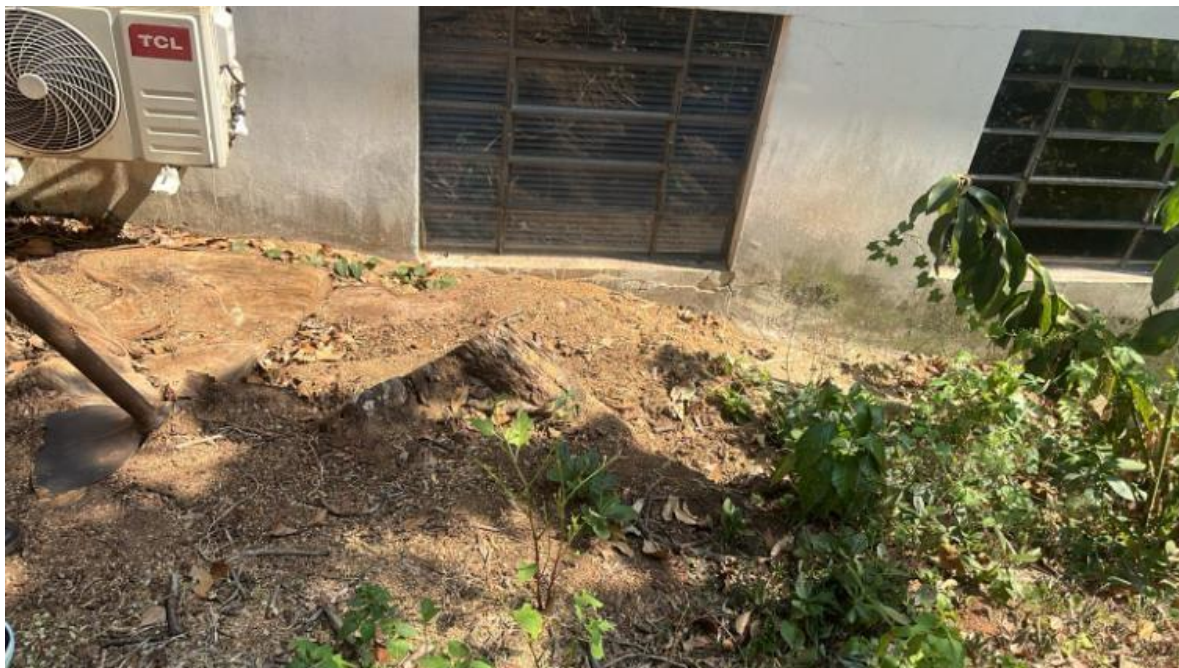
Figura 1 – Maciço de solo em contato com a edificação
