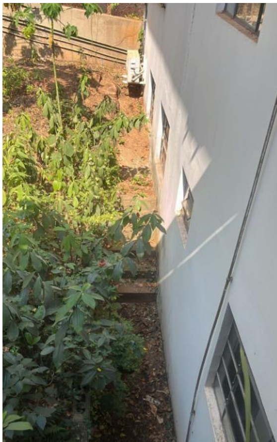
Figura 5 - Local onde será iniciado o dreno (1)
