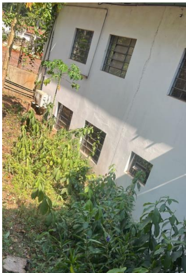
Figura 4 – Local onde será iniciado o dreno (2)
