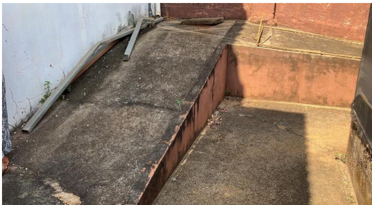
Figura 6 – Demolição da rampa
