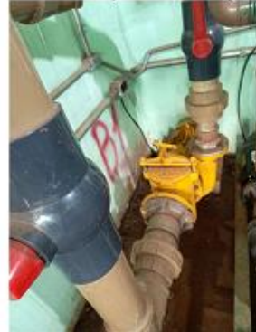
Visão da bomba jacuzzi instalada aguardando manutenção
