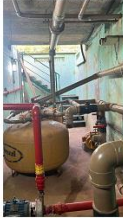
Visão da frente da casa de máquinas
