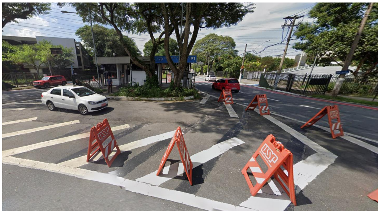
Figura 7 – Vista do local de implantação da nova Portaria 1
