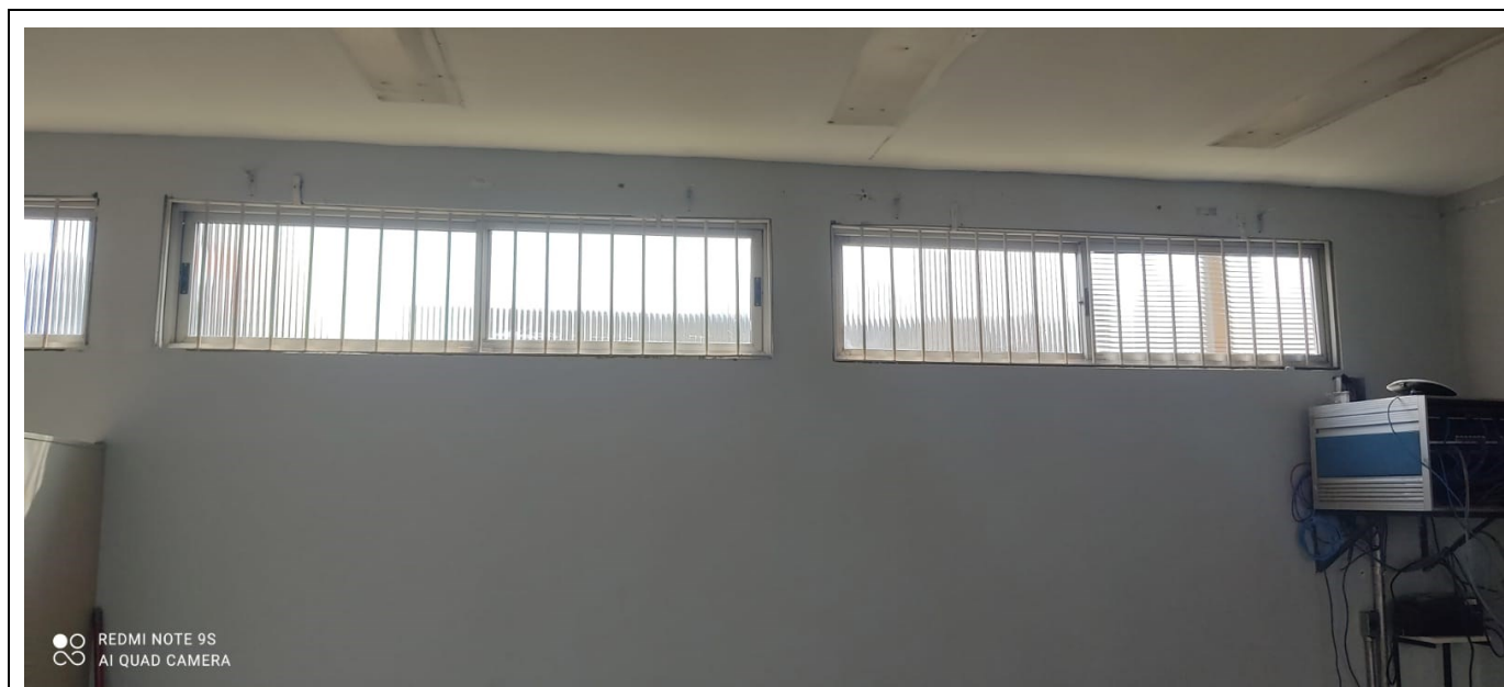
Parede 2 (Janelas 2 e 3)
