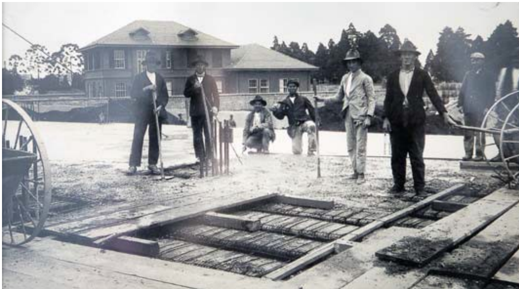
Foto sem data, provavelmente final dos anos de 1920, período da obra de construção do edifício do Instituto de Higiene (atual Faculdade de Saúde Pública) com a residência ao fundo. In: Diário Oficial do Estado de São Paulo-Seção 1, de 25 de novembro de 2015.
