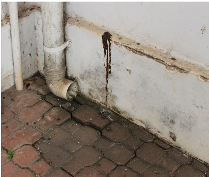
Detalhe de algumas descidas de águas pluviais junto a edificação. Resultam em uma grande carga de água junto ao embasamento.
