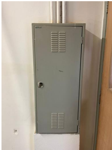
Figura 2 – Foto 1: vista geral do quadro existente (QDF-01), com a porta fechada, instalado em parede do corredor.
