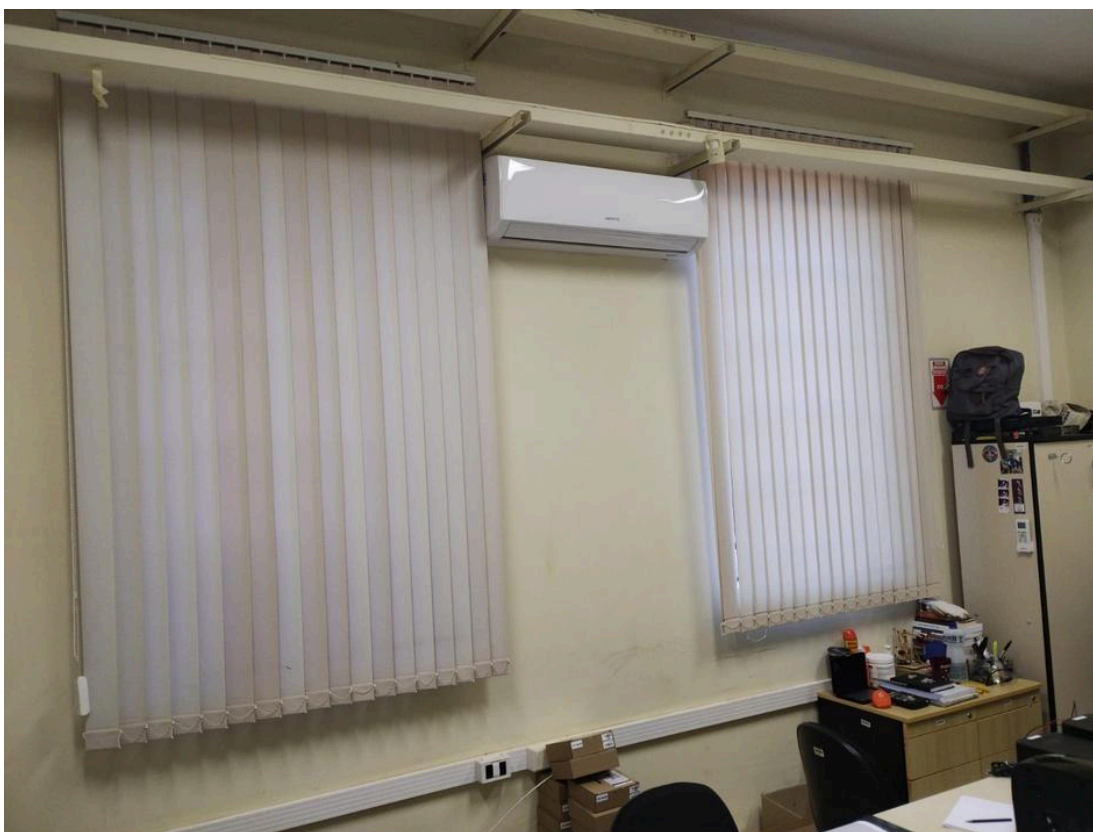
Item 16 - BLOCO A - SALA 07 – Heber
