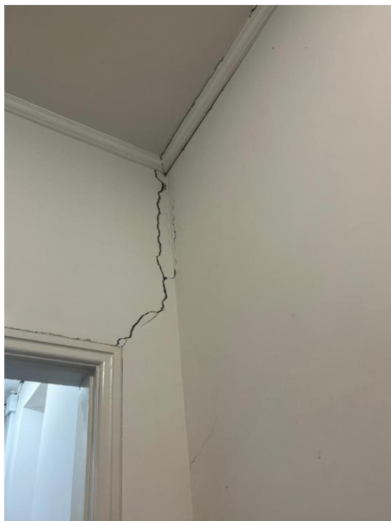
Figura 2 – Trinca presente no encontro de paredes e vão de porta
