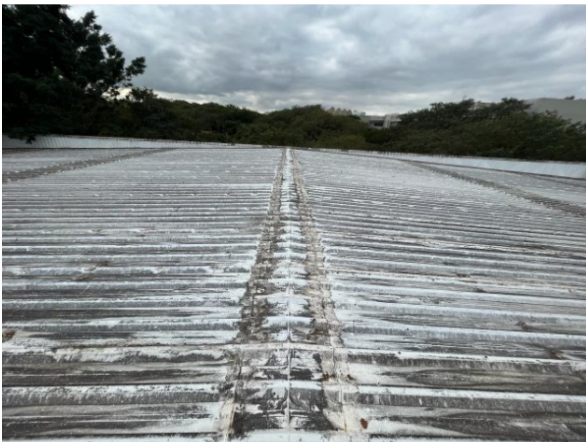
Foto da cobertura existente
