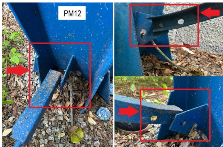
Figura 12 – Fixação parcial do elemento de contraventamento.
