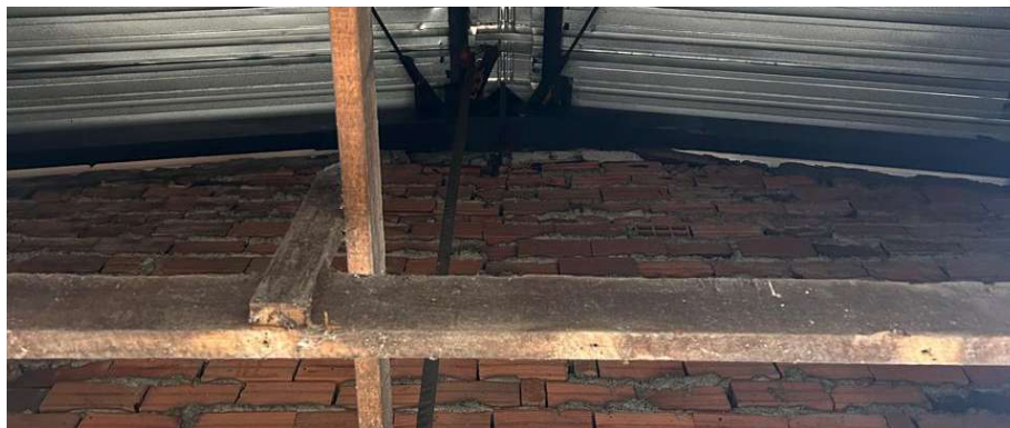
Figura 17 – Trecho fechamento de alvenaria da Parede 4 até a cobertura.
