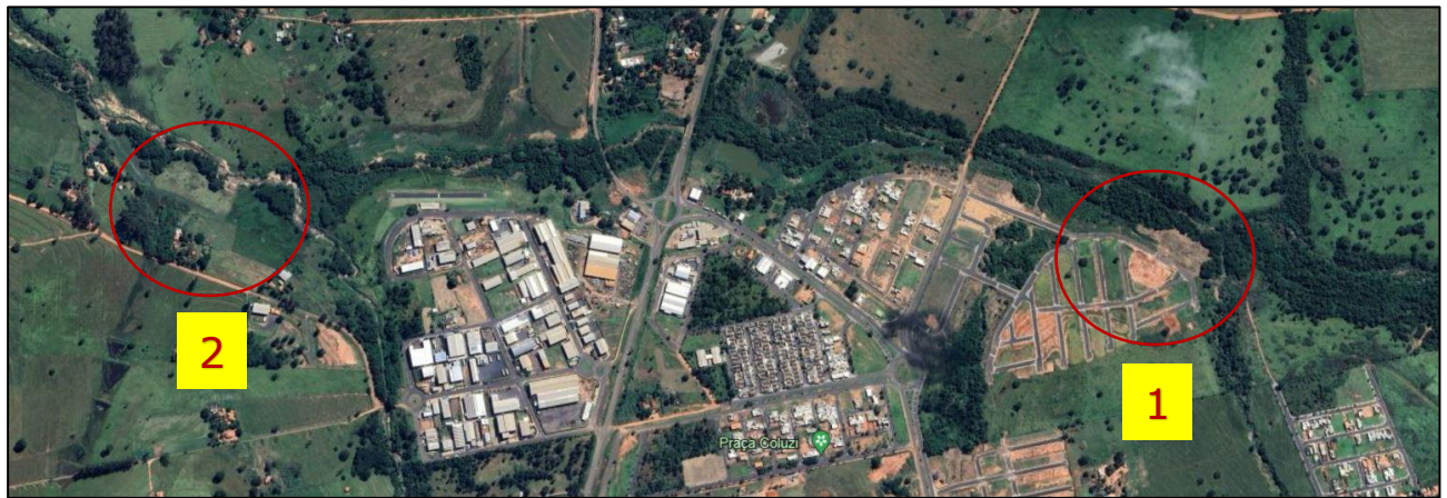
Figura 1: Interceptor com riscos iminentes de vazamentos (Ponto 1) e interceptor obstruído (Ponto 2).
