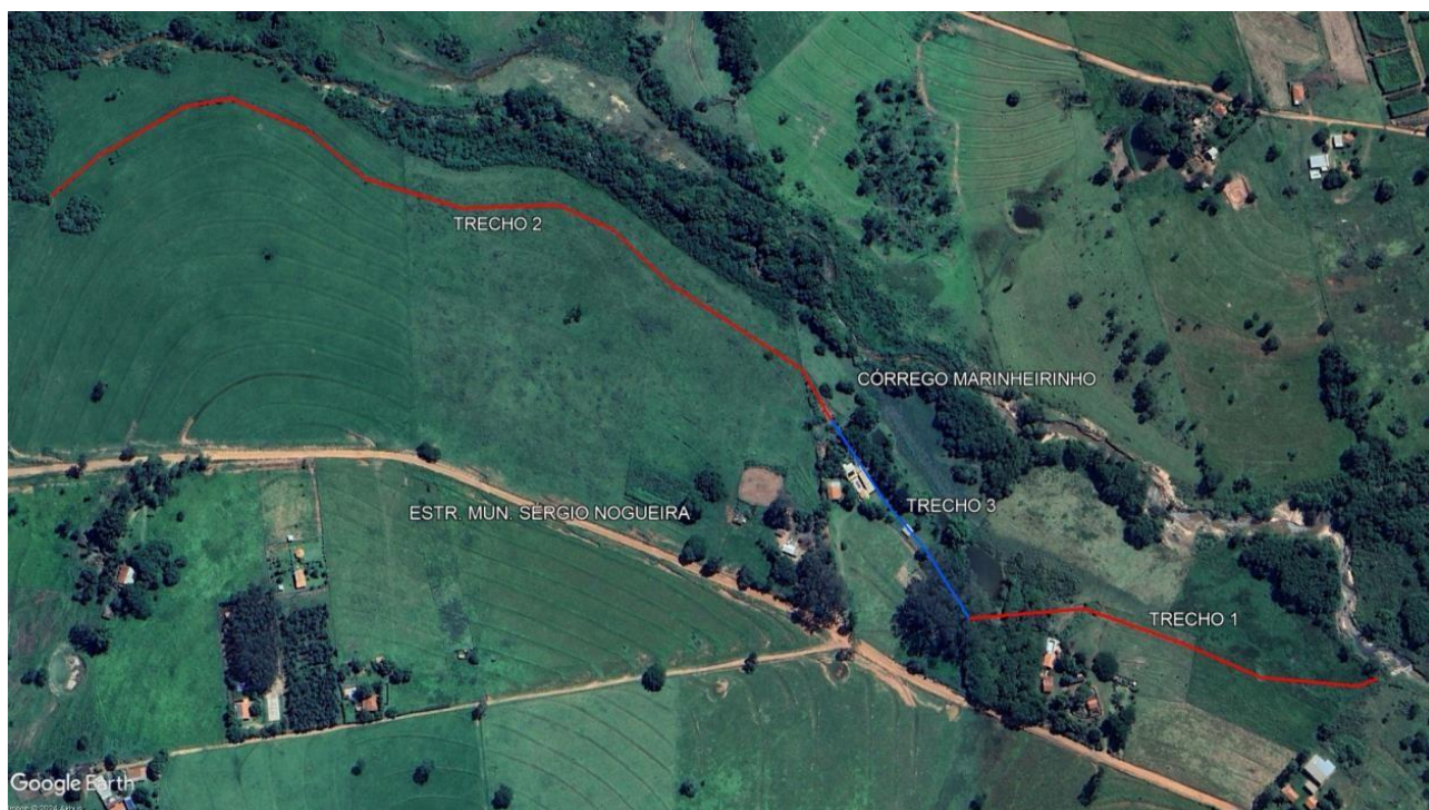
Figura 2: Trechos do Interceptor parcialmente obstruídos.
