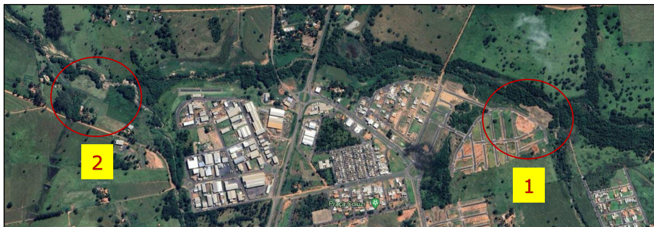
Figura 01: Interceptor com riscos iminente de vazamentos (Ponto 1) e interceptor obstruído (Ponto 2).
