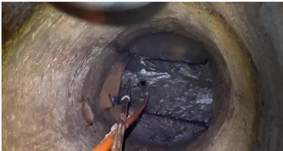
Figura 11: Serviço de hidrojato com utilização do produto químico executado dia 08/07/2025
