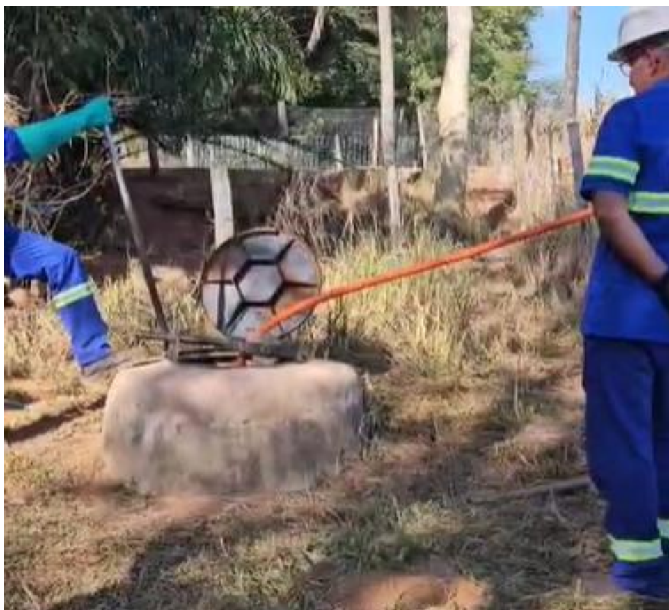
Figura 10: Serviço de hidrojato com utilização do produto químico executado dia 08/07/2025
