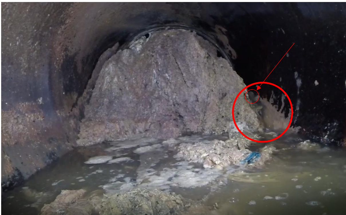
Figura 3: Sedimentos identificados durante a Contratação “Dispensa nº13/2025”
