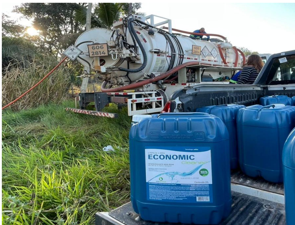
Figura 8: Serviço de hidrojato com utilização do produto químico executado dia 08/07/2025
