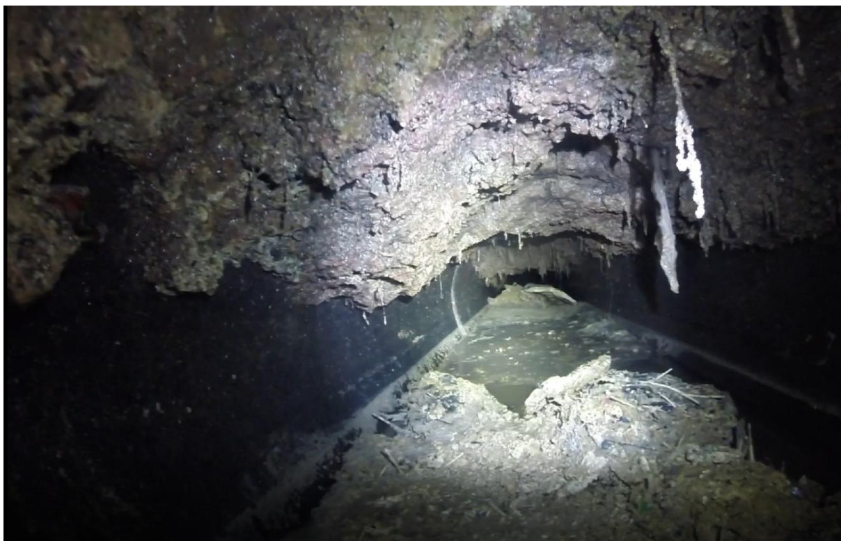
Figura 6: Sedimentos identificados durante a Contratação “Dispensa nº13/2025”
