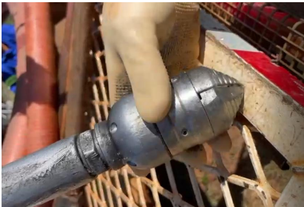
Figura 9: Serviço de hidrojato com utilização do produto químico executado dia 08/07/2025
