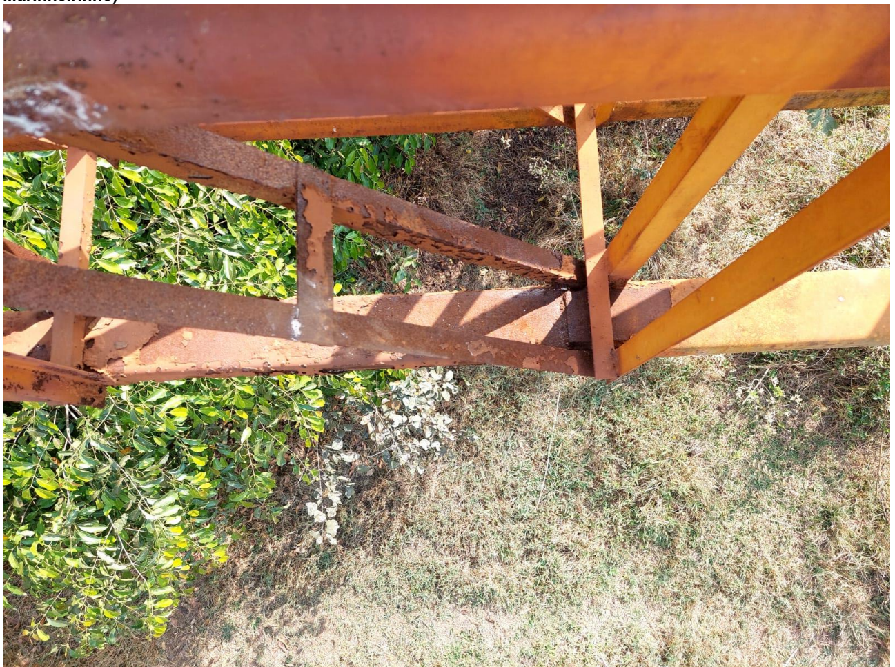
Figura 8: Detalhe de barras da treliça com sinais de oxidação e ferrugem (Travessia sobre o Córrego Marinheirinho)
