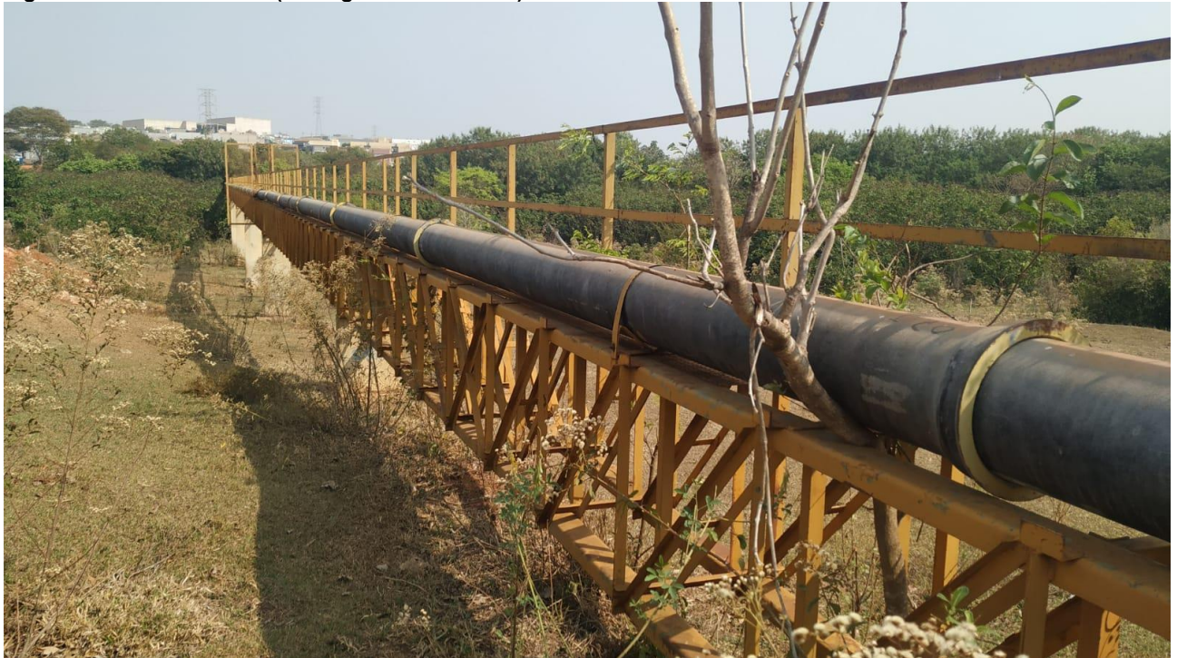
Figura 8: Detalhe de barras da treliça com sinais de oxidação e ferrugem (Travessia sobre o Córrego Marinheirinho)
