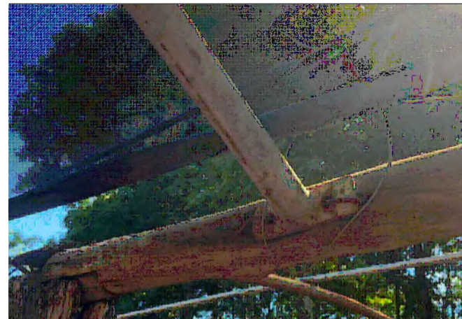
05 FIXAÇÃO ESTRUTURA METÁLICA S/ ESC
