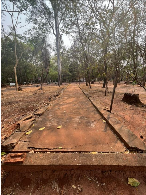
Figura 13: Campo de bocha existente, deteriorado e em desuso
