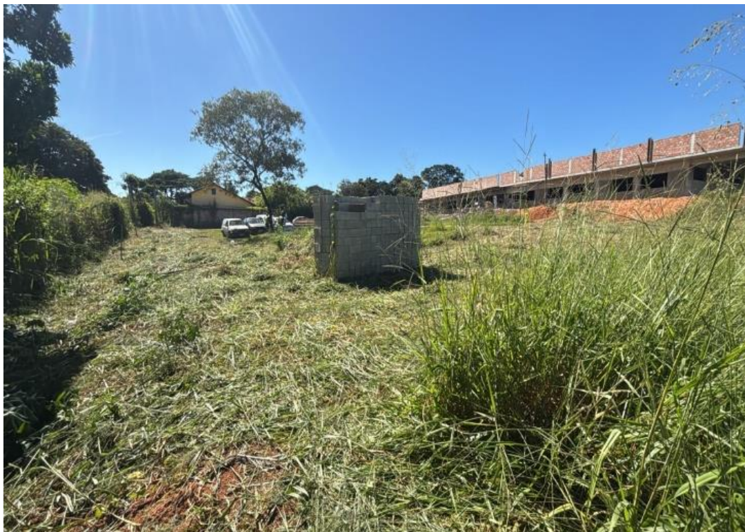
Foto 3 - LOCAL DE IMPLANTAÇÃO DA QUADRA: LATERAL DIREITA
