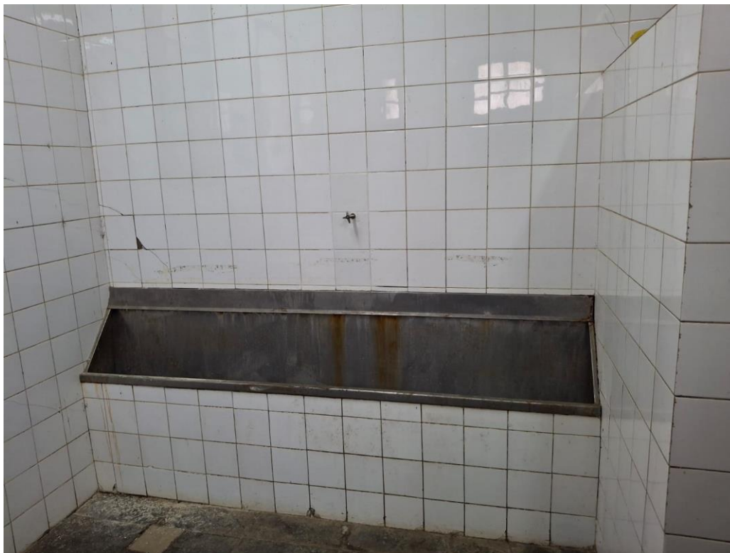
Foto 8 – Sanitário masculino subsolo.
