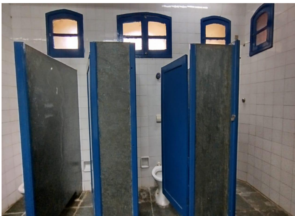
Foto 5 – Sanitário feminino subsolo.
