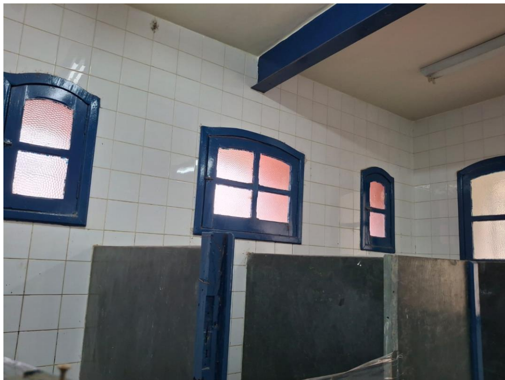
Foto 7 – Sanitário masculino subsolo.
