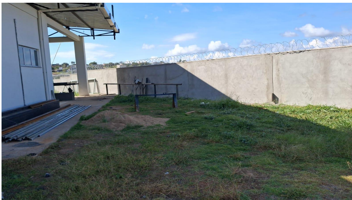
Foto 2 - Local a ser construído o foyer.
