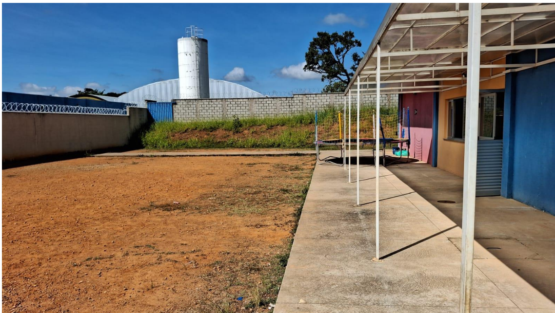
Foto 8 – Local a ser construída a cobertura da creche.
