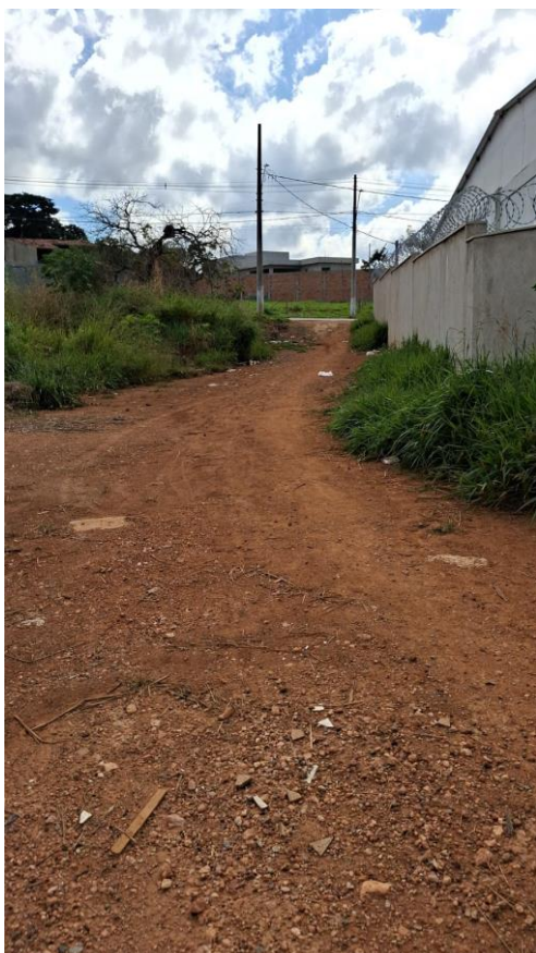
Foto 6 – Local a ser construído o acesso ao foyer do Auditório.
