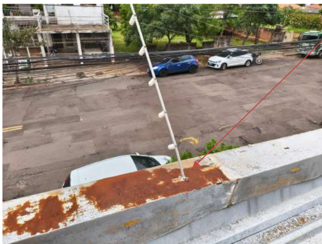
Perfuração de pingadeira para instalação de cerca elétrica
