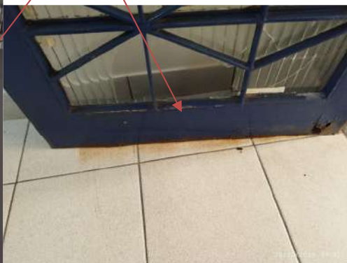
Porta com corrosão e vidro quebrado
