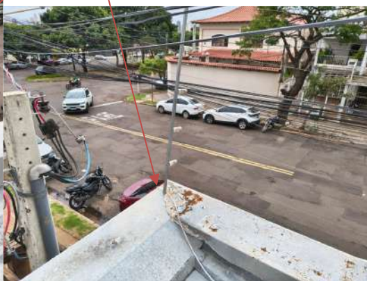
Perfuração de pingadeira para instalação de cerca elétrica
