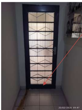
Porta com corrosão e vidro quebrado
