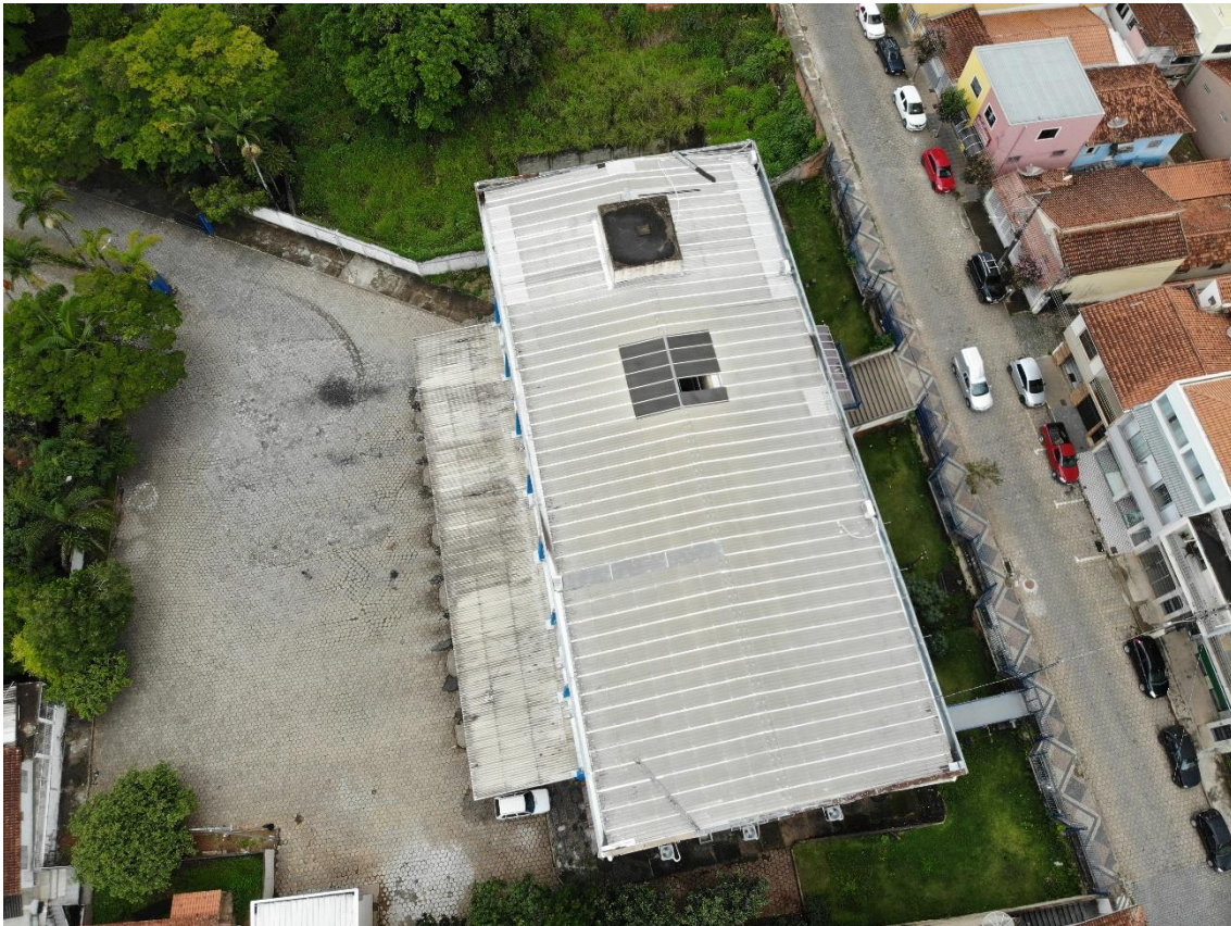
Figura 1 – Imagem aérea do telhado da Câmara Municipal de Borda da Mata.
