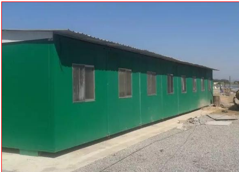
Figura 1 - Canteiro de obras em container - Fonte: Google
