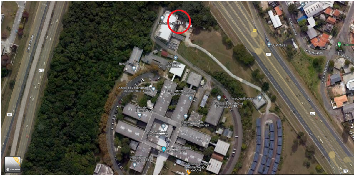
Figura 1 - Localização aproximada da escada externa ao prédio da Farmacologia no Campus Jardim das Américas.
