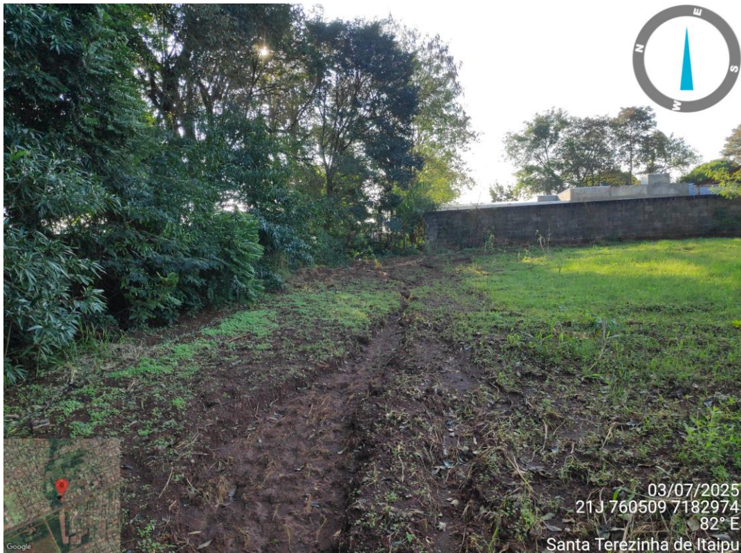
FOTO 24 – Vista geral do traço de drenagem. (Fonte: Autoria própria, registrada em 03/07/2025).
