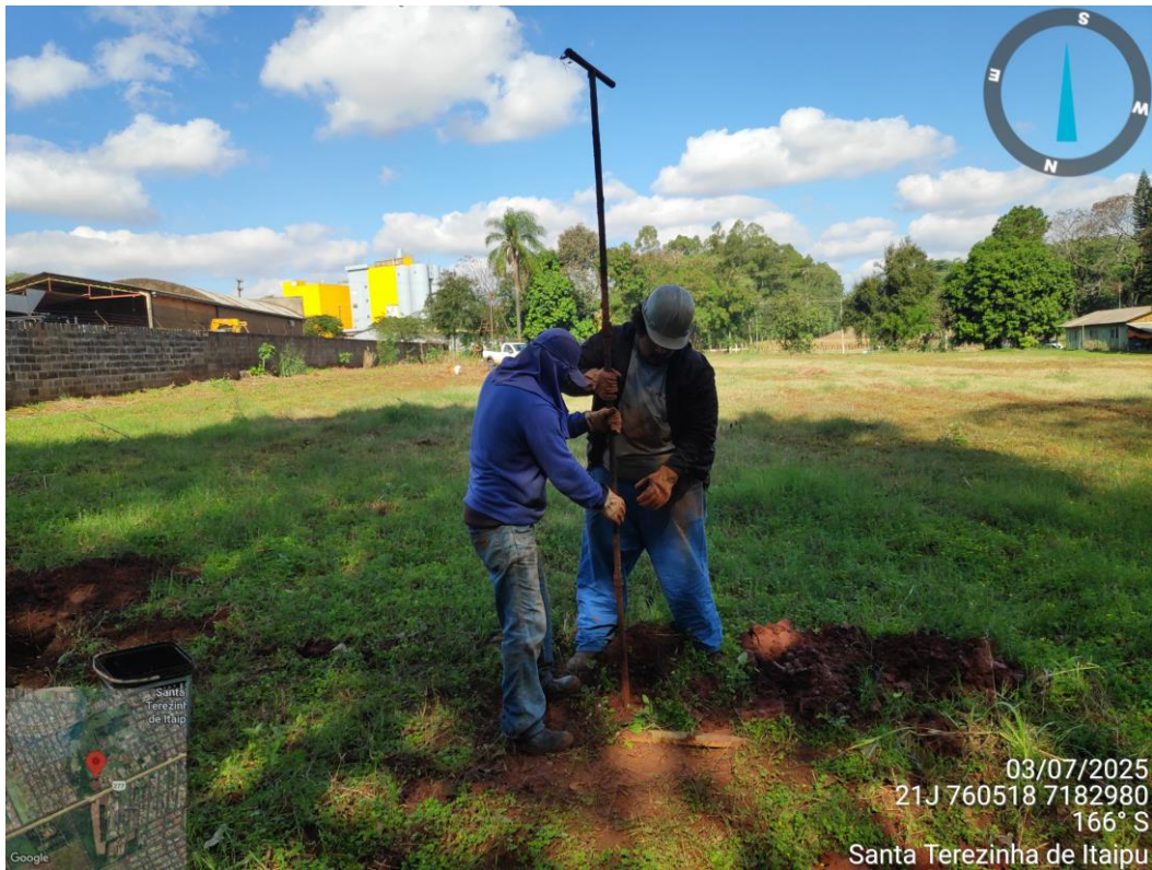
FOTO 03 – Sondagem ST 03. (Fonte: Autoria própria, registrada em 03/07/2025)..
