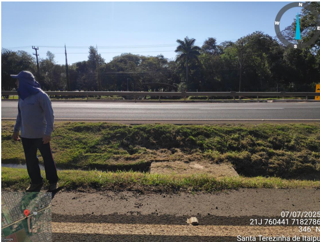
FOTO 09 – Caixa de passagem com águas circulando sendo direcionadas para o Parque Ecológico Domingos Zanette. (Fonte: Autoria própria, registrada em 07/07/2025).
