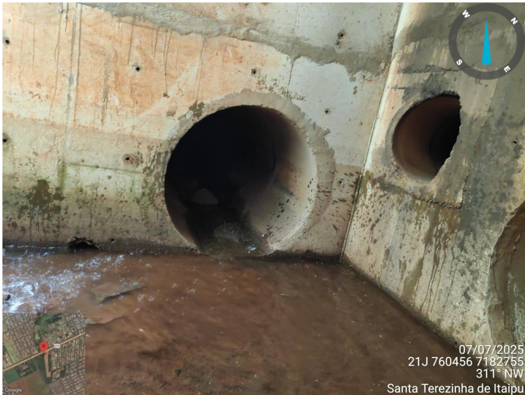
FOTO 07 – Caixa de passagem com águas circulando vindo do ponto de surgência. (Fonte: Autoria própria, registrada em 07/07/2025).
