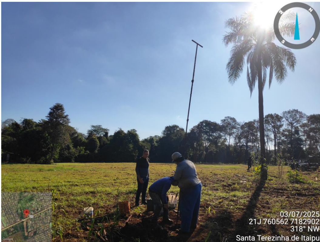
FOTO 04 – Sondagem ST 04. (Fonte: Autoria própria, registrada em 03/07/2025).
