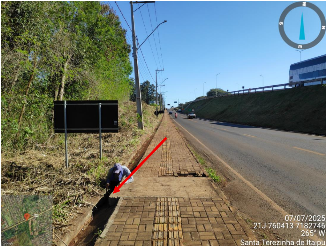
FOTO 05 – Ponto de surgência da nascente que foi tubulada. (Fonte Autoria própria, registrada em 07/07/2025).
