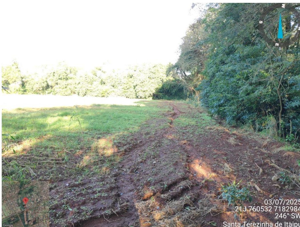
FOTO 23 – Vista geral do traço de drenagem. (Fonte: Autoria própria, registrada em 03/07/2025).
