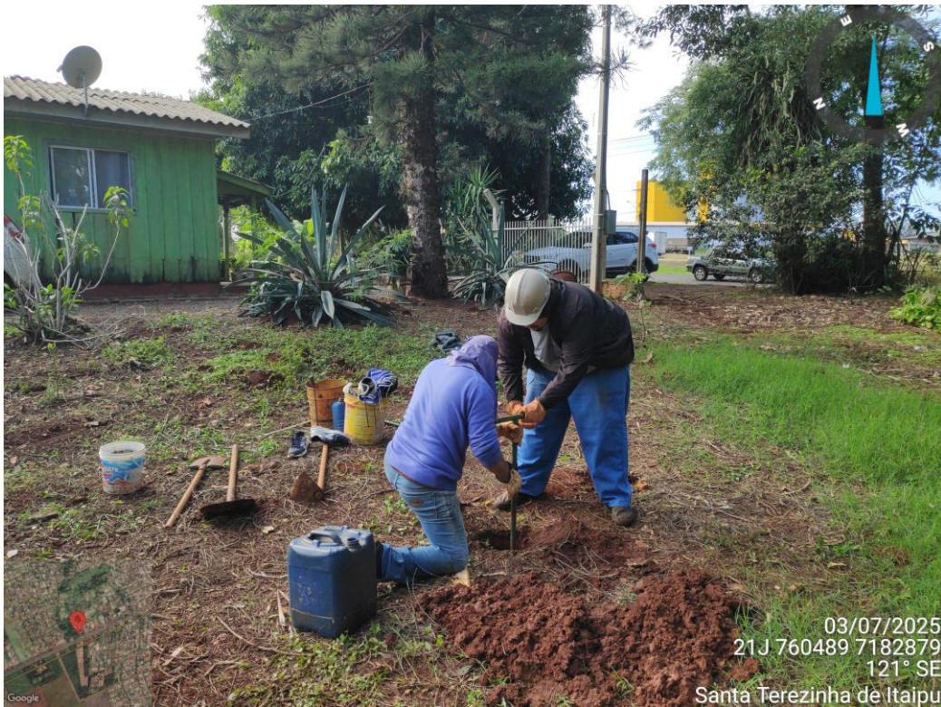
FOTO 01 – Sondagem ST 01. (Fonte: Autoria própria, registrada em 03/07/2025).
