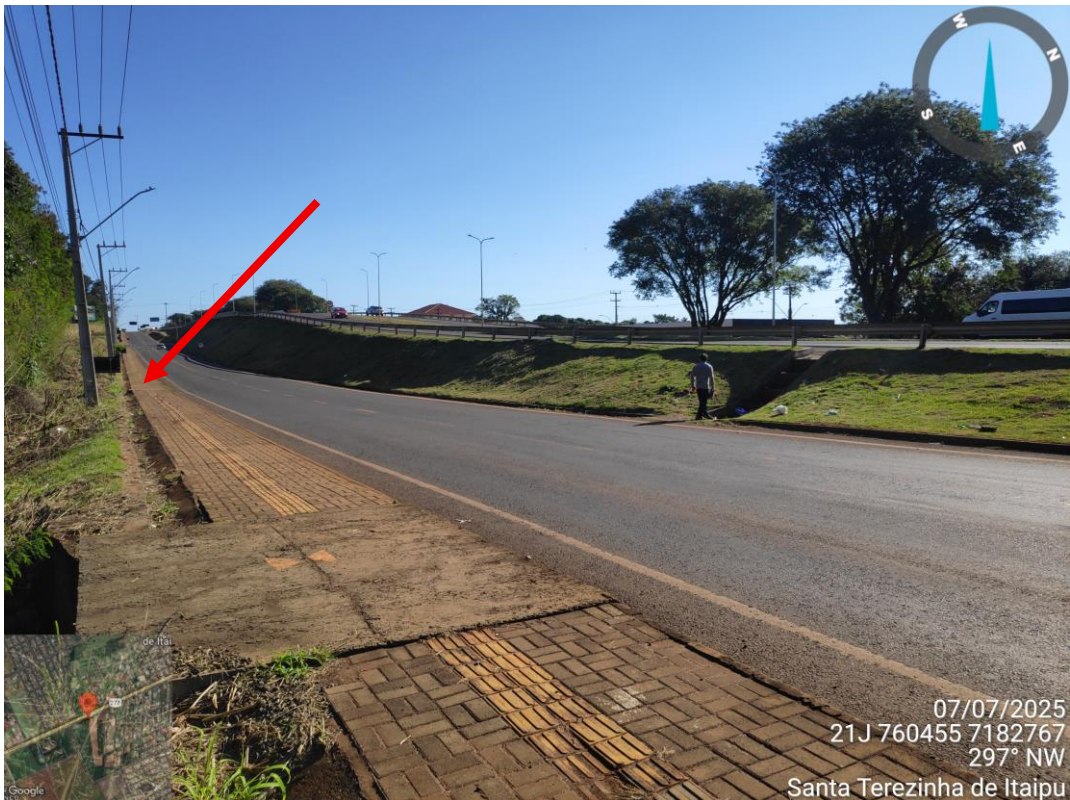
FOTO 06 – Ponto de surgência da nascente que foi tubulada. (Fonte: Autoria própria, registrada em 07/07/2025).
