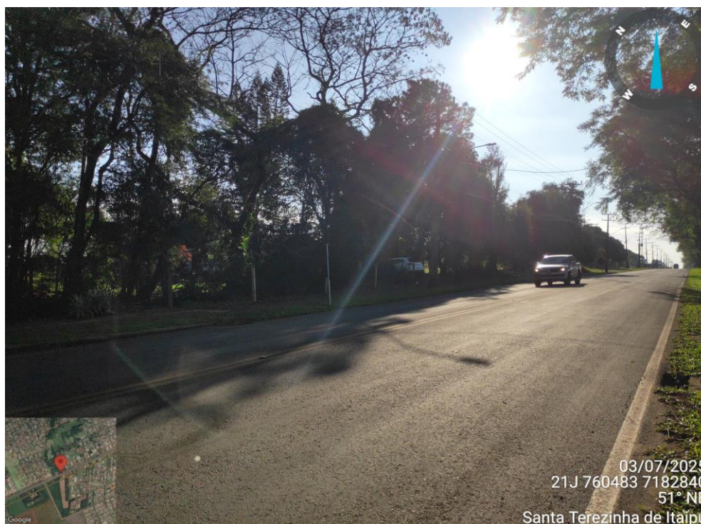
FOTO 26 – Av. Adolpho Lollato e a esquerda área em estudo. (Fonte: Autoria própria, registrada 03/07/2025).
