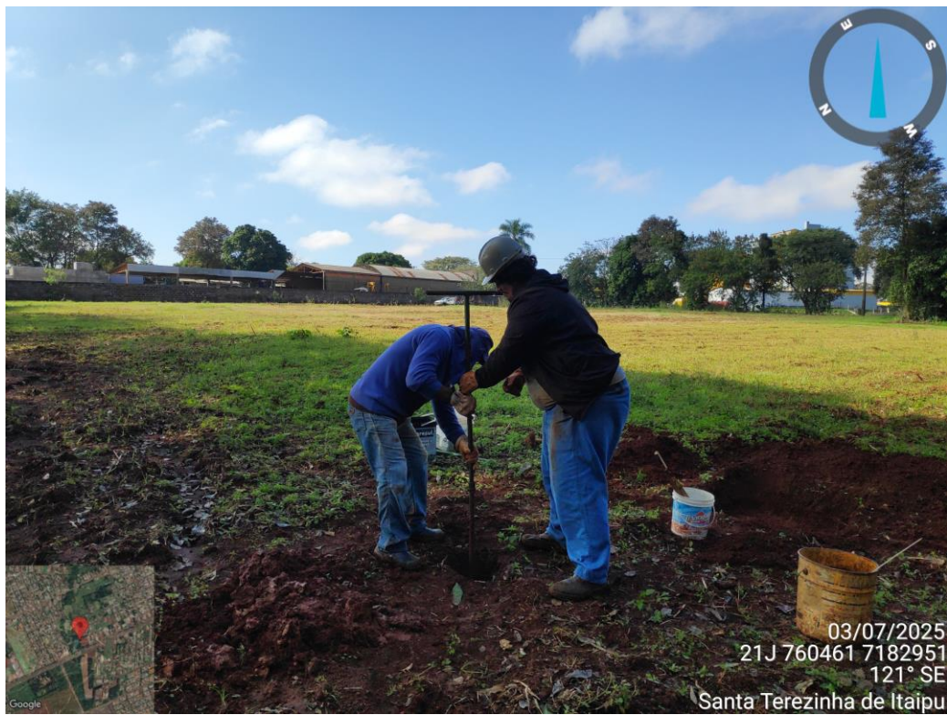
FOTO 02 – Sondagem ST 02. (Fonte: Autoria própria, registrada em 03/07/2025).
